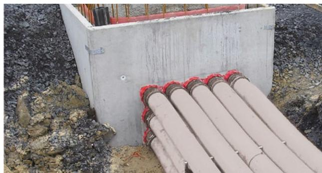
KES MA90 D - Anschluss an Dichtpackung HSI90
