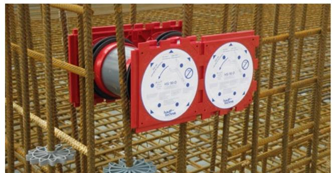
Doppeldichtpackung HSI90 als Paket in Schalung eingesetzt
