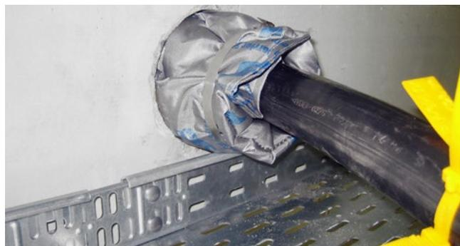
HSS - Einbau in Kernbohrung mit HRD Ringraumdichtungen
