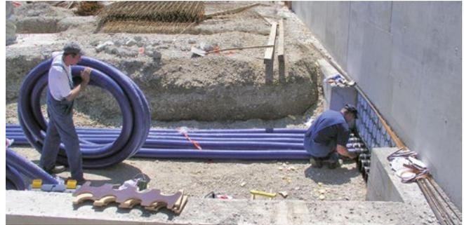
Verlegung Kabeleinführungs-System KES150 MA mit Manschettentechnik
