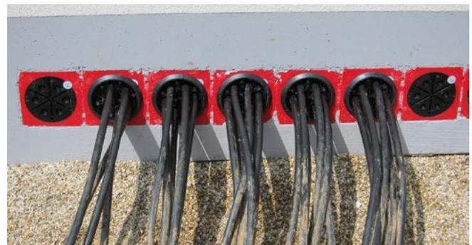
Abdichtung von Niederspannungskabeln mit HSI150 DG 6x10-36
