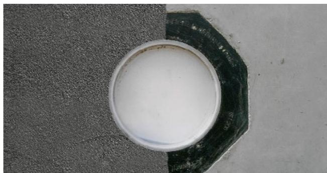
Betoniertes UFR mit PMBC
