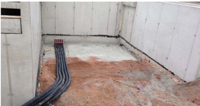
Wellrohranschluss HSI90 D1x75 KS WR
