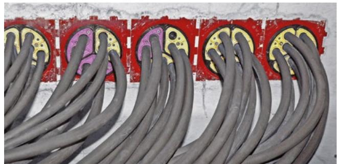
Kabelzug durch HSI-Dichtpackungen mit SEGMENTO-Systemeinsätzen
