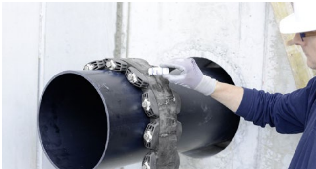
GKD400 - Montagevorbereitung mit Gleitmittel GM
