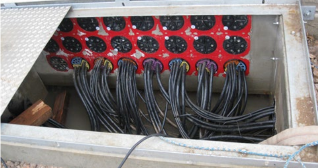
HSI150 - Dichtpackungen bestückt mit SEGMENTO-Abdichtung von Steuerleitungen in einem Schalthaus
