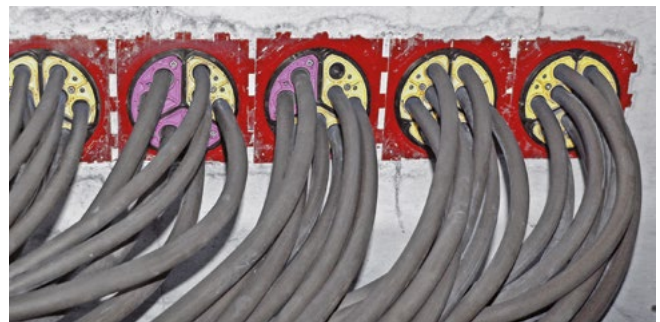
Kabelzug durch HSI-Dichtpackungen mit SEGMENTO-Systemeinsätzen
