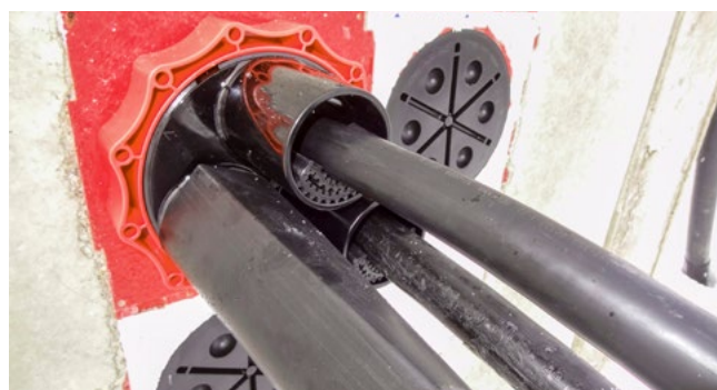
Zentrierband im Systemdeckelstutzen des HSI150 D3x58 WS
