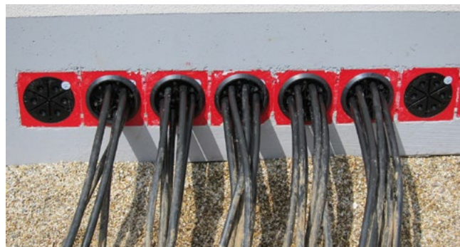
Abdichtung von Niederspannungskabeln mit HSI150 DG 6x10-36
