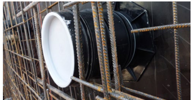
UFR in Schalung
