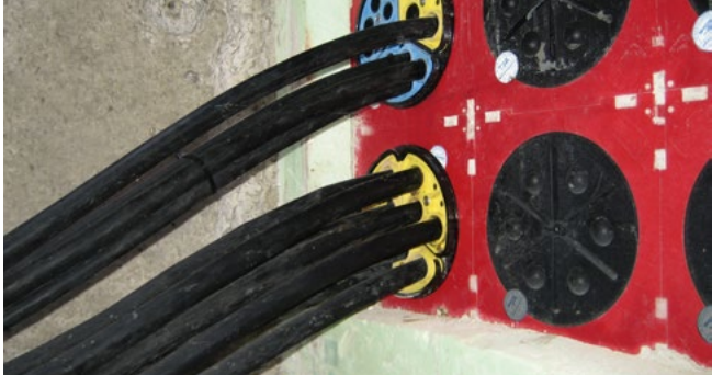
Abdichtung von Kabeln für Straßenbeleuchtung mit SEGMENTO
