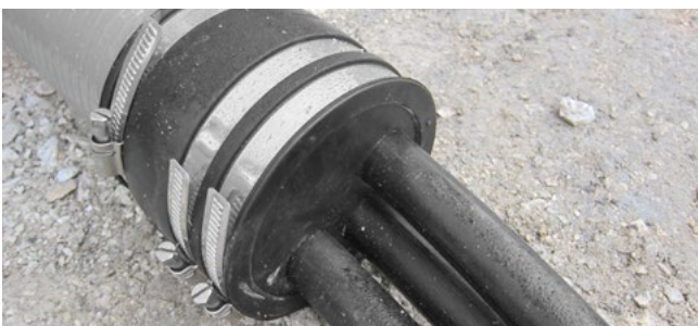
Abdichtung im Erdreich am Ende des Spiralschlauches Hateflex14150 mit dem Abdichtset KES150 MA WE160 SG 3x22-58 SET
