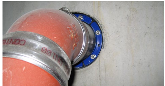
HSD200 C 1x159 b40 A2/EPDM55 in verzinktem Fest- und Losflansch
