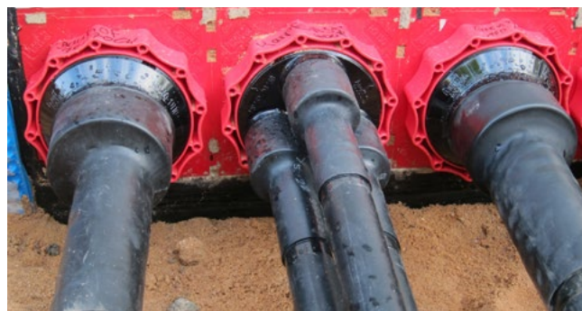
Zentrierband im Systemdeckelstutzen des HSI150 D3x58 WS
