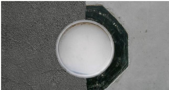
Betoniertes UFR mit PMBC
