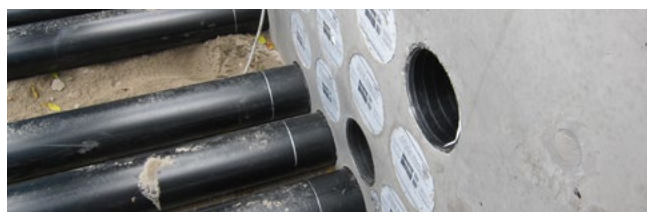
HSI150 GSM Varia als Paket eingesetzt
