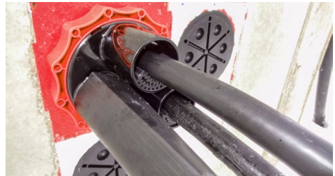
Zentrierband im Systemdeckelstutzen des HSI150 D3x58 WS
