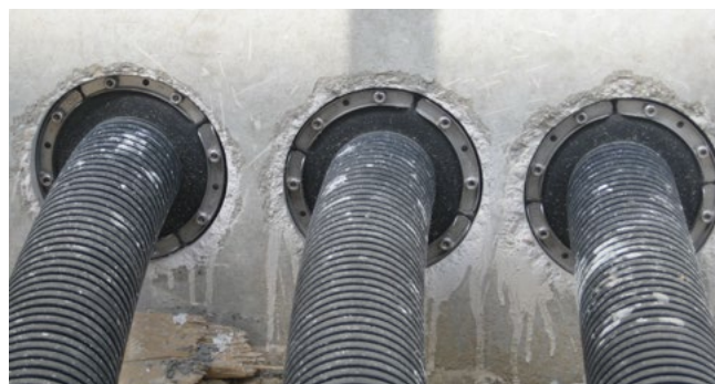
Detailansicht: Clipping/Dichtung
