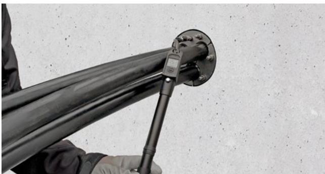
HRD150 PV G in Kernbohrung
