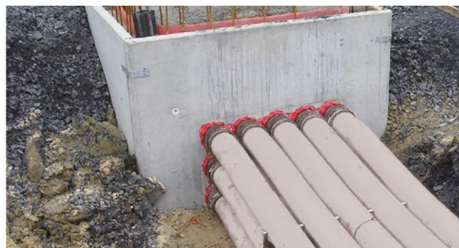
KES MA90 D - Anschluss an Dichtpackung HSI90
