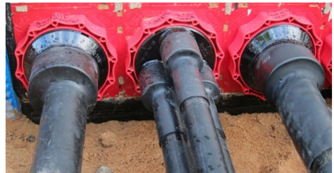
Zentrierband im Systemdeckelstutzen des HSI150 D3x58 WS
