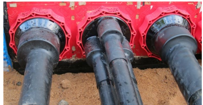
Zentrierband im Systemdeckelstutzen des HSI150 D3x58 WS
