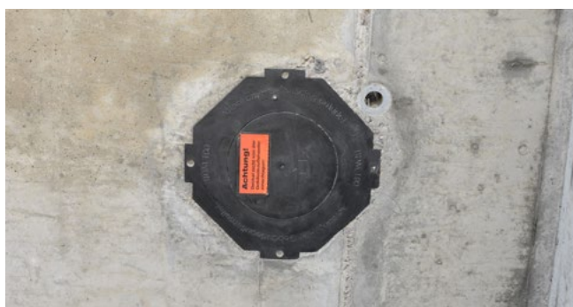
Praxisbild UDM/UDME in betonierter Wand
