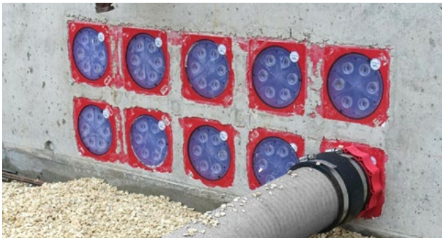
Druckdichter Anschluss an die HSI150-Dichtpackungen
