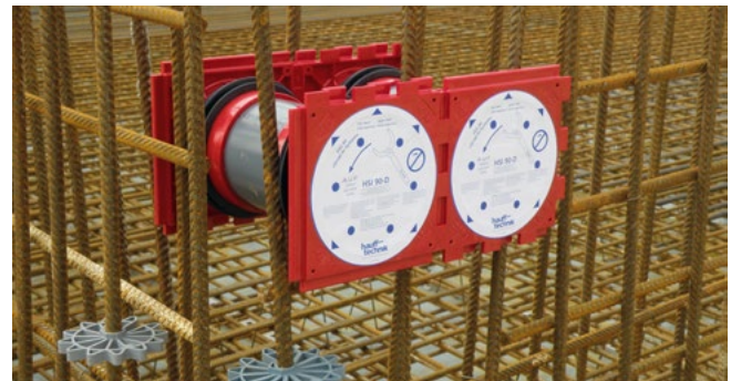
Doppeldichtpackung HSI90 als Paket in Schalung eingesetzt
