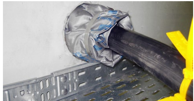
HSS - Einbau in Kernbohrung mit HRD Ringraumdichtungen
