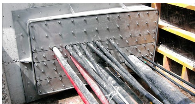
Geteilter Rechteck-Flansch mit Mehrfachbelegung
