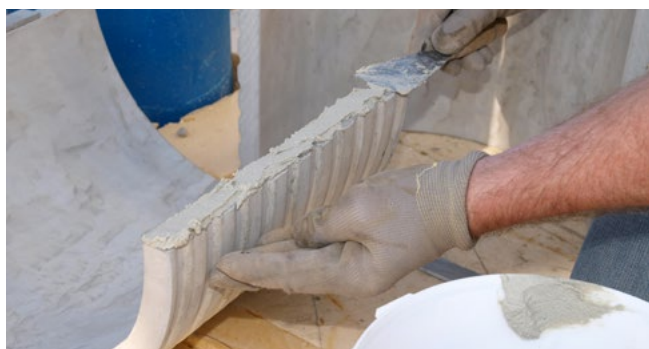
FZRG350/300 mit Spachtelmasse aus Montageset MSET FZRG
