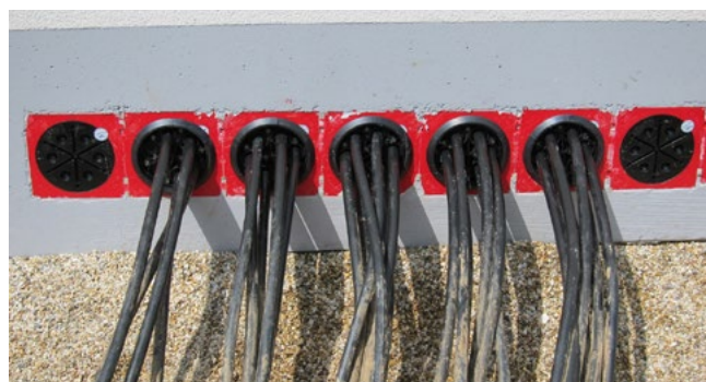
Abdichtung von Niederspannungskabeln mit HSI150 DG 6x10-36
