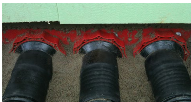
Wellrohranschluss mit Kaltschrumpftechnik HSI150 D1x110 KS WR
