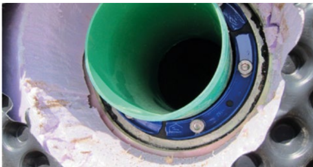
HSD150 C 1x110 b40 A2/EPDM55 in verzinktem Fest- und Losflansch
