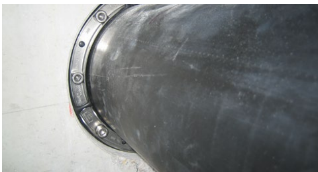
Detailansicht - HSD, Kontrollöffnung und Anzugsreihenfolge der Schrauben
