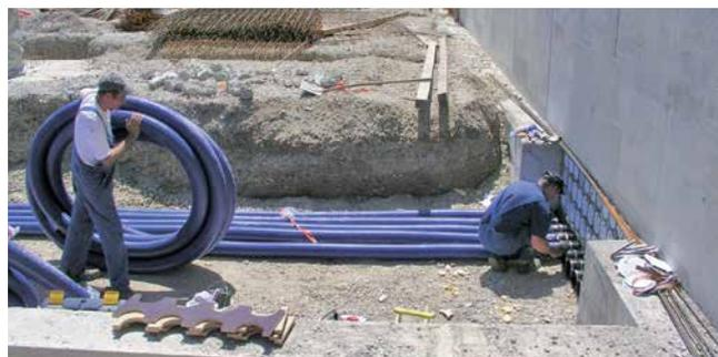
Verlegung Kabeleinführungssystem KES-M 150 mit Manschettentechnik
