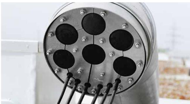
Montierter Dichteinsatz SKD in Schwanenhals SHD200
