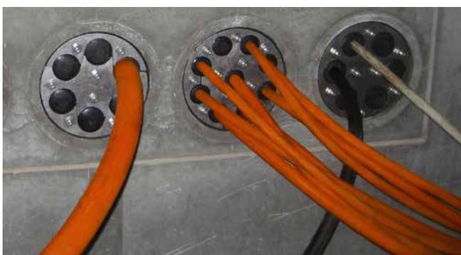
HRD150 SG eingebaut in Faserzementfutterrohre
