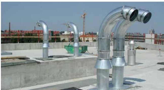
Montierte SHD200 vor Verlegung der Dachabdichtung
