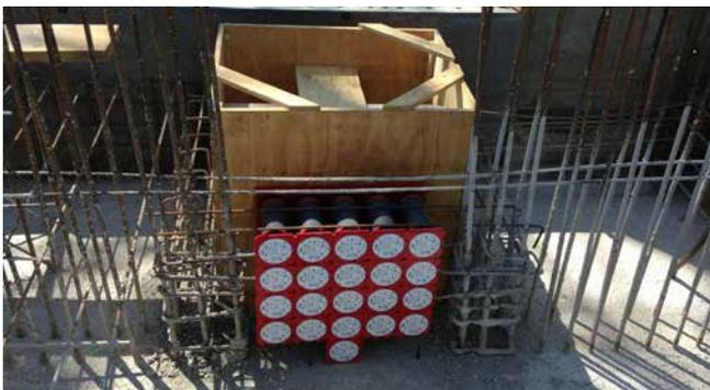
Einbau von Doppeldichtpackung HSI90 vor dem Betonieren
