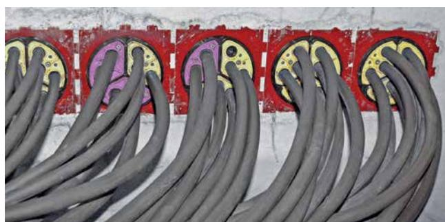
Kabelzug durch HSI-Dichtpackungen mit SEGMENTO-Systemeinsätzen
