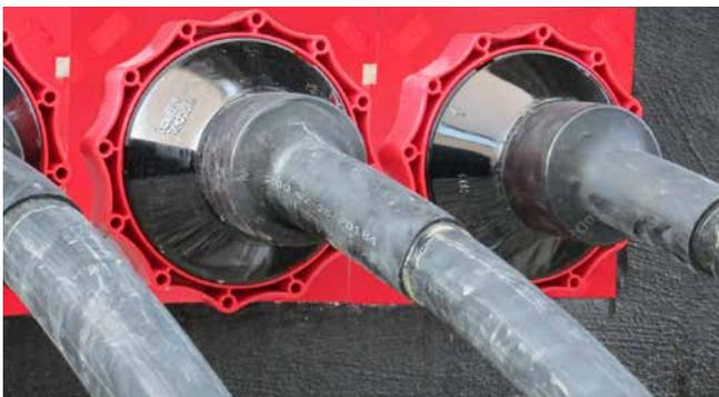
Stationseinführung: Niederspannungskabel abgedichtet mit HSI150 D1x80 WS
