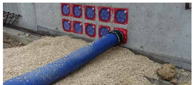
Anschluss des Kabeleinführungssystems KES MA150 D
