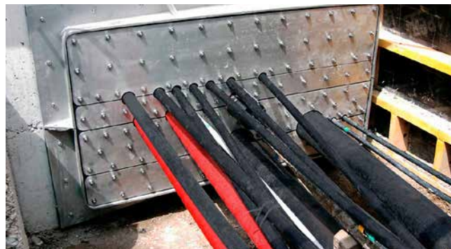
Geteilter Rechteck-Flansch mit Mehrfachbelegung
