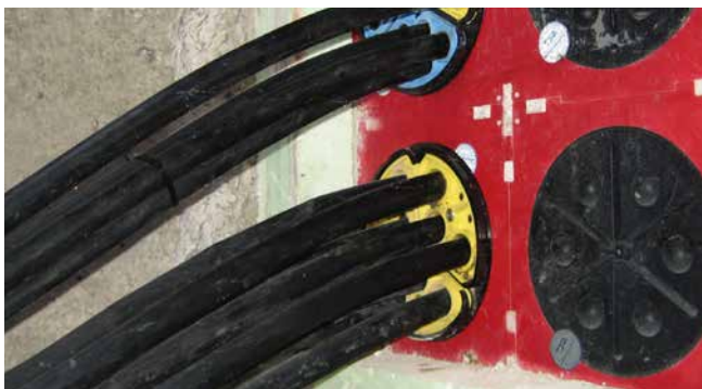
Abdichtung von Kabeln für Straßenbeleuchtung mit SEGMENTO
