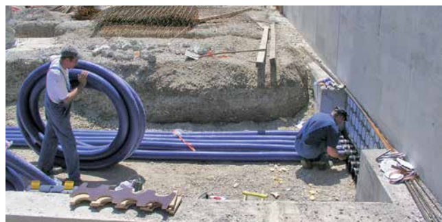
Verlegung Kabeleinführungssystem KES-M 150 mit Manschettentechnik
