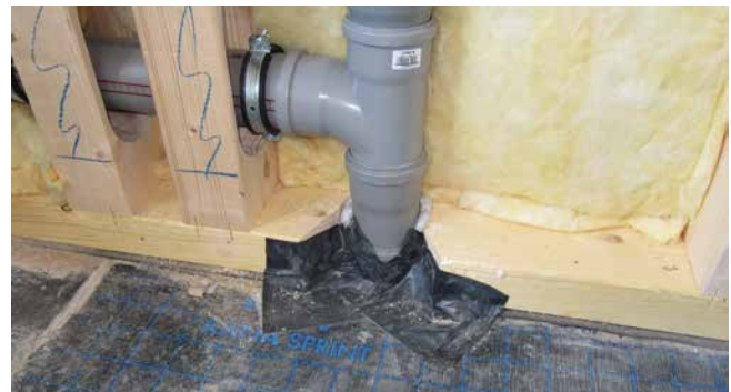
Schwierigkeit: Einbindung der Dampfsperre
