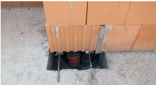
Schwierigkeit: nachträglicher gas- und dampfdichter Verschluss
