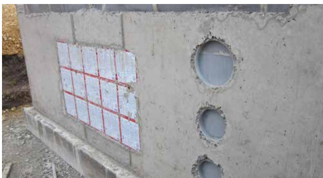
ZVR150 und ZVR200 einbetoniert neben HSI150
