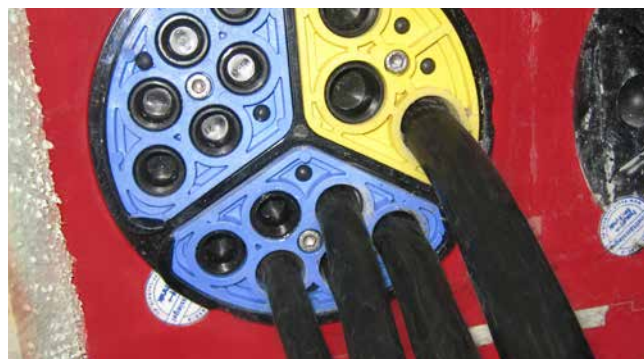
HSI150 SEGMENTO mit integrierter Drehmomentkontrolle und Blindstopfen
