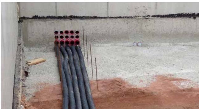
Wellrohranschluss HSI90 D1x75 KS WR
