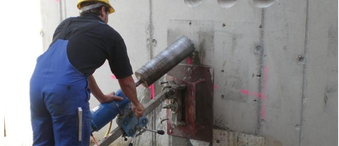
Herstellen von vertikal und horizontal verlaufenden Diamantschrägborungen für die Aufnahme von HRD-Dichteinsätzen
