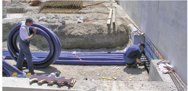
Verlegung Kabeleinführungs-System KES150 MA mit Manschettentechnik
