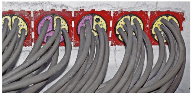
Kabelzug durch HSI-Dichtpackungen mit SEGMENTO-Systemeinsätzen
