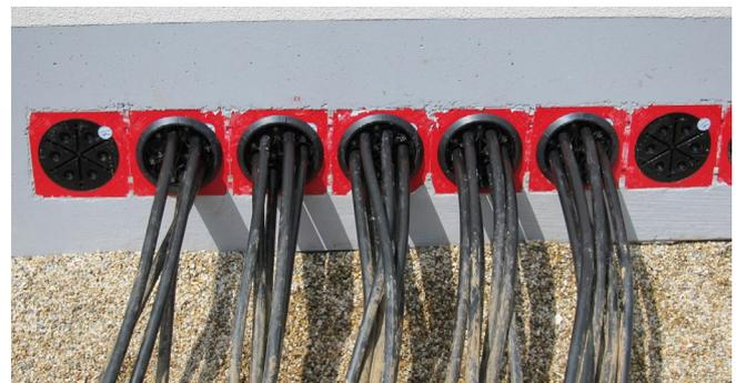
Abdichtung von Niederspannungskabeln mit HSI150 DG 6x10-36
