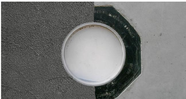
Betoniertes UFR mit PMBC
