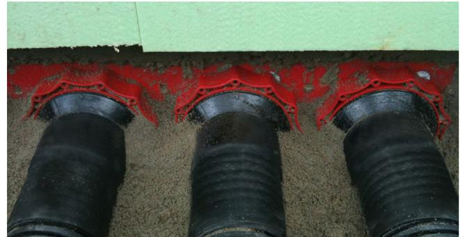
Wellrohranschluss mit Kaltschrumpftechnik HSI150 D1x110 KS WR
