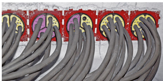
Kabelzug durch HSI-Dichtpackungen mit SEGMENTO-Systemeinsätzen
