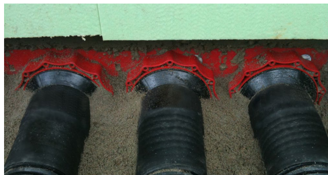
Wellrohranschluss mit Kaltschrumpftechnik HSI150 D1x110 KS WR
