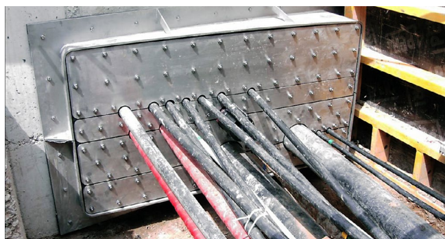
Geteilter Rechteck-Flansch mit Mehrfachbelegung
