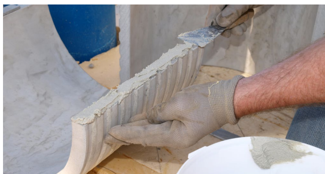
FZRG350/300 mit Spachtelmasse aus Montageset MSET FZRG
