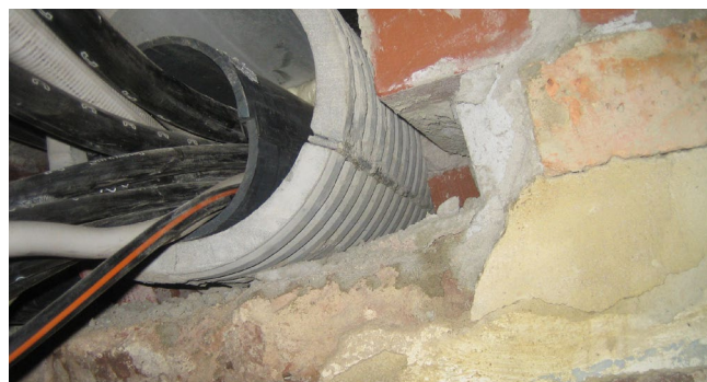
FZRG150/350 - Renovierung Mauerwerk
