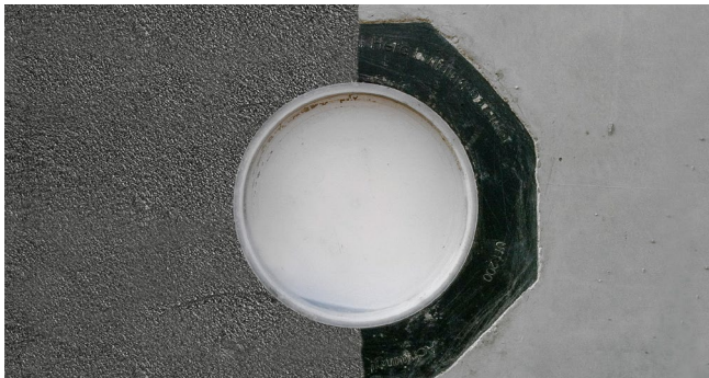
Betoniertes UFR mit PMBC
