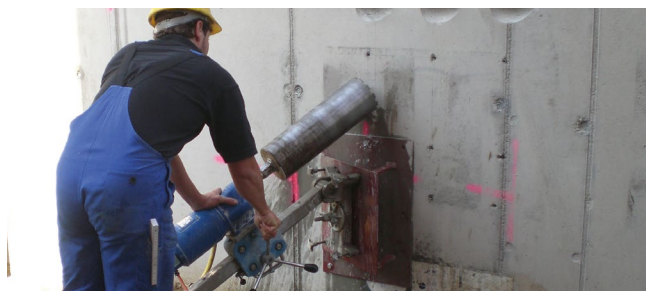
Herstellen von vertikal und horizontal verlaufenden Diamantschrägborungen für die Aufnahme von HRD-Dichteinsätzen
