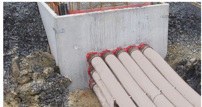
KES MA90 D - Anschluss an Dichtpackung HSI90
