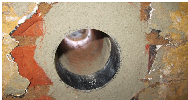
SFR nachträglich im Mauerwerk eingearbeitet
