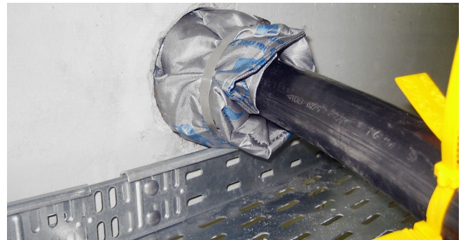
HSS - Einbau in Kernbohrung mit HRD Ringraumdichtungen
