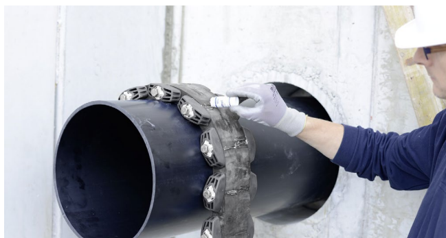
GKD400 - Montagevorbereitung mit Gleitmittel GM
