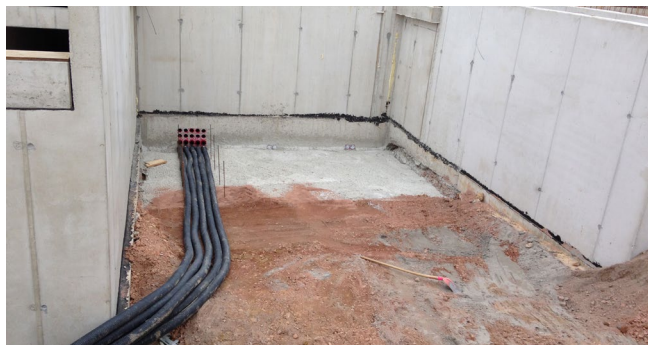
Wellrohranschluss HSI90 D1x75 KS WR
