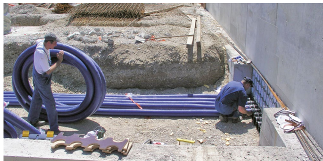
Verlegung Kabeleinführungs-System KES150 MA mit Manschettentechnik
