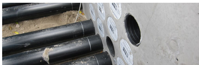
HSI150 GSM Varia als Paket eingesetzt
