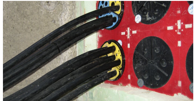
Abdichtung von Kabeln für Straßenbeleuchtung mit SEGMENTO
