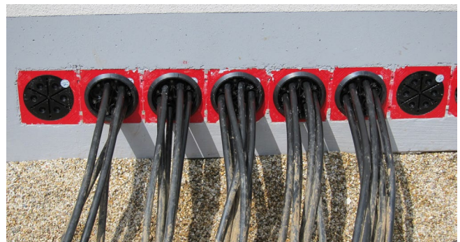
Abdichtung von Niederspannungskabeln mit HSI150 DG 6x10-36
