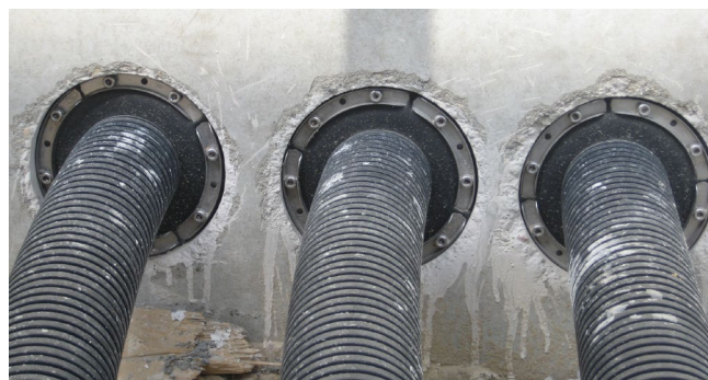
Detailansicht: Clipping/Dichtung
