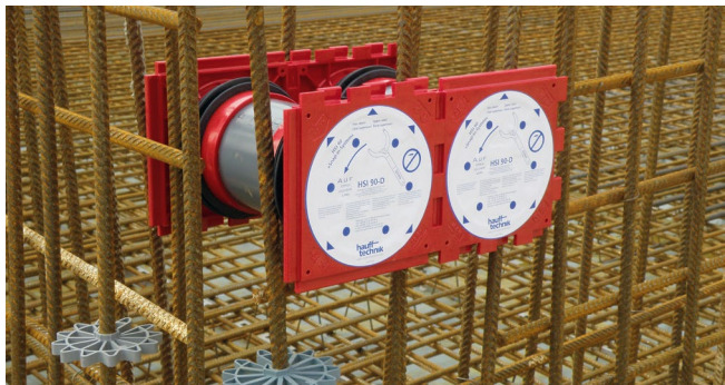
Doppeldichtpackung HSI90 als Paket in Schalung eingesetzt
