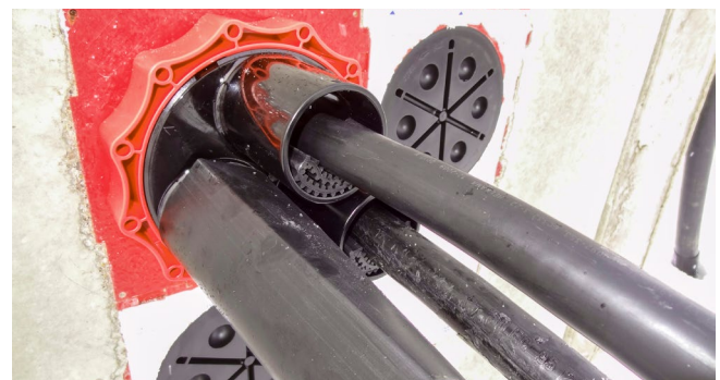
Zentrierband im Systemdeckelstutzen des HSI150 D3x58 WS
