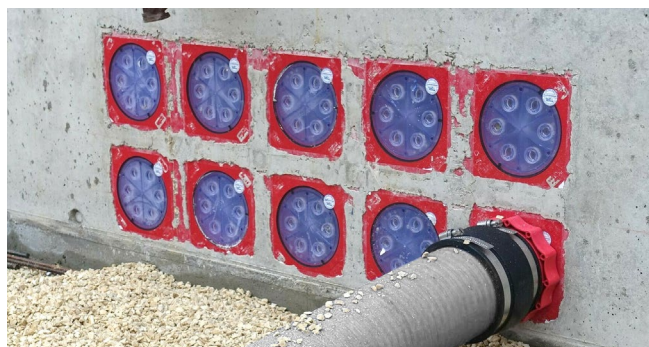
Druckdichter Anschluss an die HSI150-Dichtpackungen
