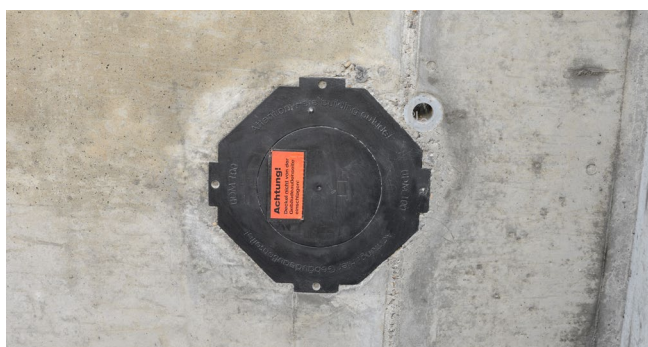
Praxisbild UDM/UDME in betonierter Wand
