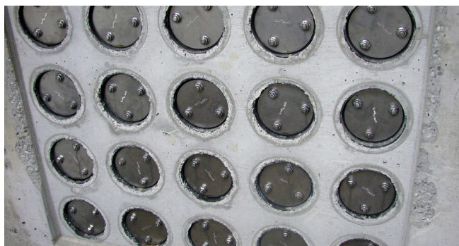
FZR100/240 Abdichtung Rohrtrasse
