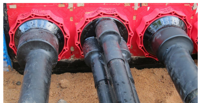
Zentrierband im Systemdeckelstutzen des HSI150 D3x58 WS
