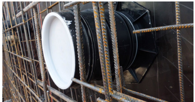
UFR in Schalung
