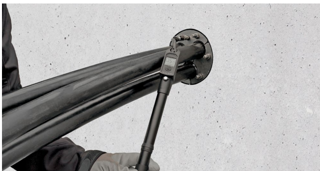
HRD150 PV G in Kernbohrung
