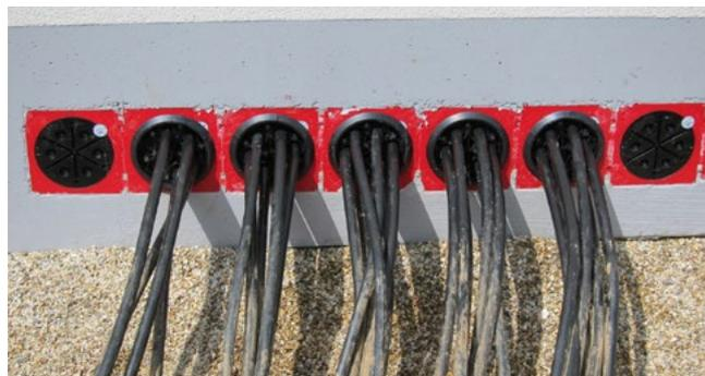
Abdichtung von Niederspannungskabeln mit HSI150 DG 6x10-36
