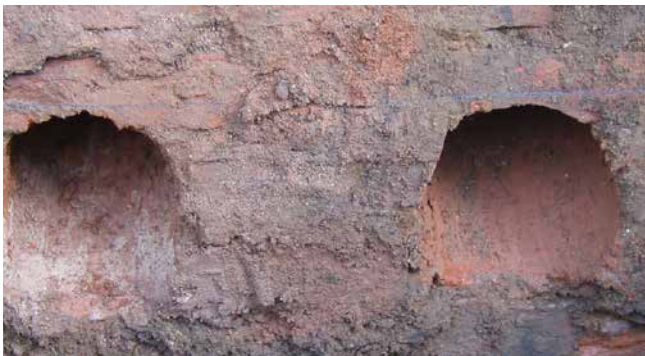
Schräge Kernbohrung in porösem Mauerwerk
