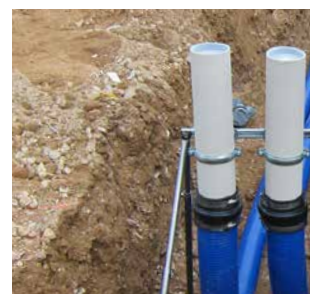
Reihenanzordnung 2x KES90 MA ZVR100/500 an der Aufstellvorrichtung KES FUBO-FIX AV
