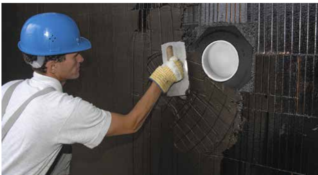
UFR in Mauerwerk
