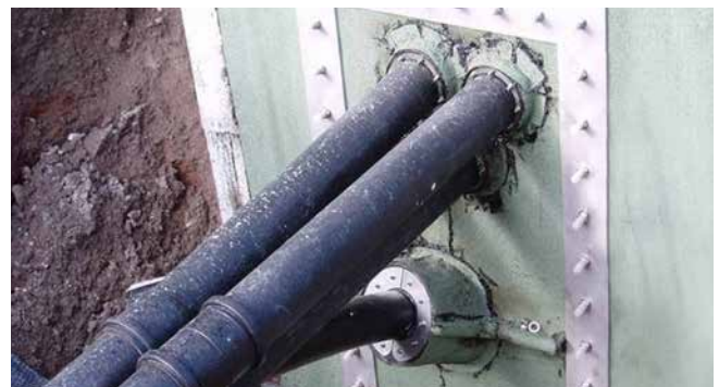
Geteilter Fest-/Losflansch in Anlehnung an DIN 18533
