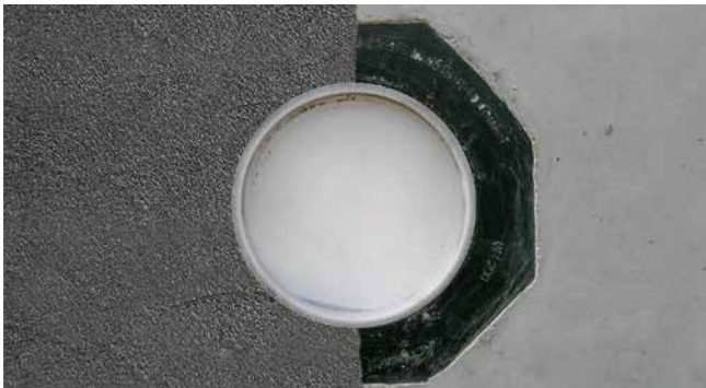
Betoniertes UFR mit PMBC
