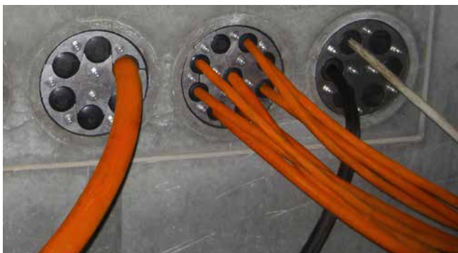
HRD150 SG eingebaut in Faserzementfutterrohre
