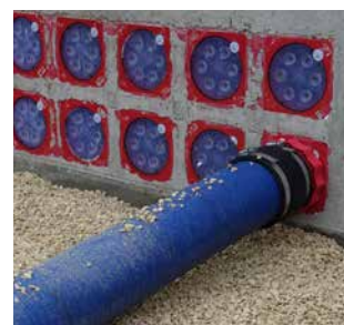
Druckdichter Anschluss an die HSI150-Dichtpackungen
