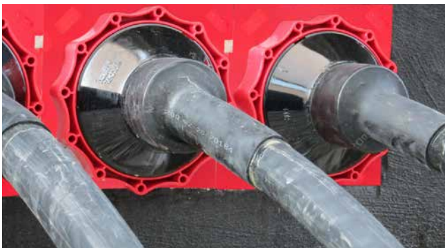
Stationseinführung: Niederspannungskabel abgedichtet mit HSI150 D1x80 WS
