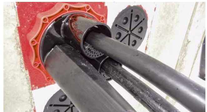
Zentrierband im Systemdeckelstutzen des HSI150 D3x58 WS
