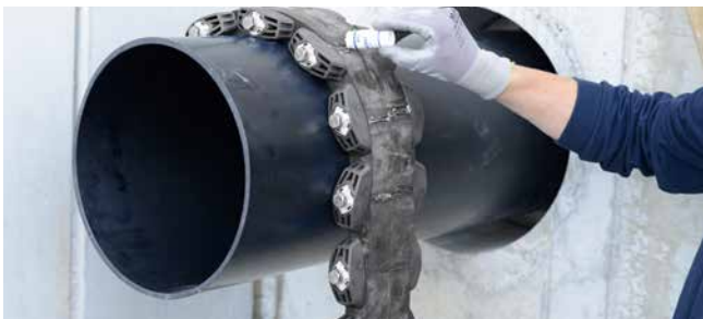
GKD400 – Montagevorbereitung mit Gleitmittel GM
