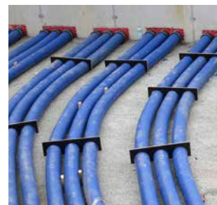
KES MA90 D und Spiralschlauch Hateflex14090
