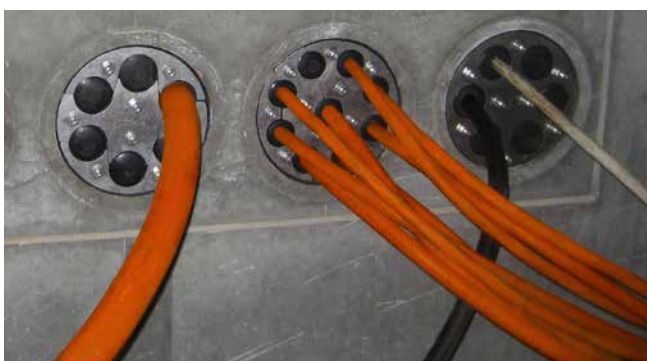
HRD150 SG eingebaut in Faserzementfutterrohre
