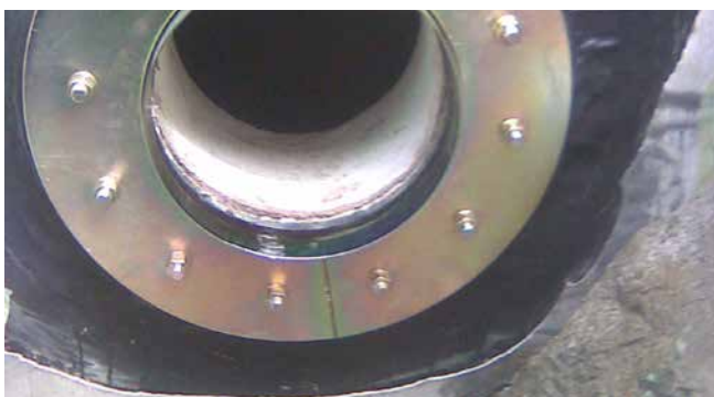
FLFA 400 A3C Entwässerungsanbindung
