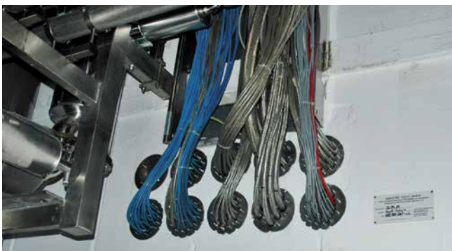
HRD150 G b30 mit Mehrfachbelegung
