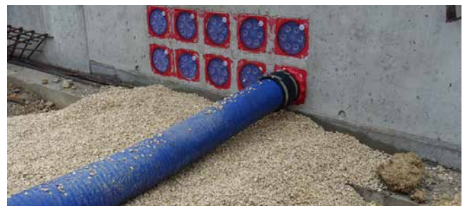
Anschluss des Kabeleinführungssystems KES MA150 D
