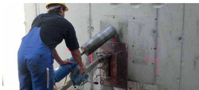
Herstellen von vertikal und horizontal verlaufenden Diamantschrägboreungen für die Aufnahme von HRD-Dichteinsätzen
