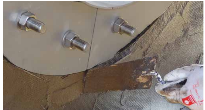
FLFE 1x200/X Edelstahlausführung mit Anbindung an PMBC mittels Vlies-Zulage, s. Seite 79 und Folgende
