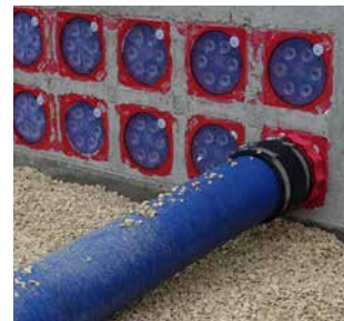
Druckdichter Anschluss an die HSI150-Dichtpackungen
