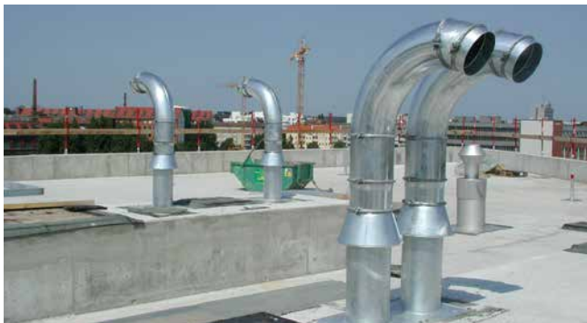
Montierte SHD200 vor Verlegung der Dachabdichtung
