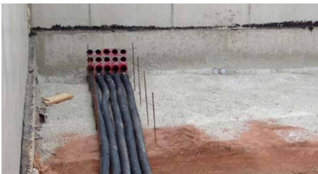
Wellrohranschluss HSI90 D1x75 KS WR
