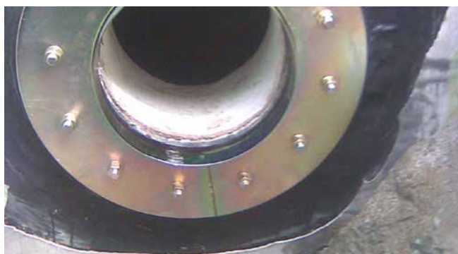
FLFA 400 A3C Entwässerungsanbindung
