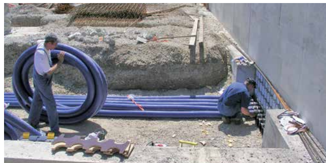
Verlegung Kabeleinführungssystem KES-M 150 mit Manschettentechnik
