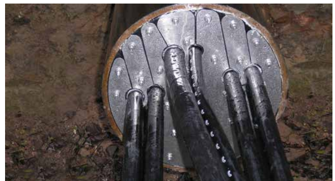
HRD200 G b30 in einem Stahlrohr
