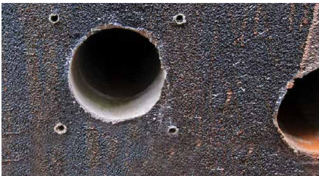
Kernbohrung und Dübellöcher
