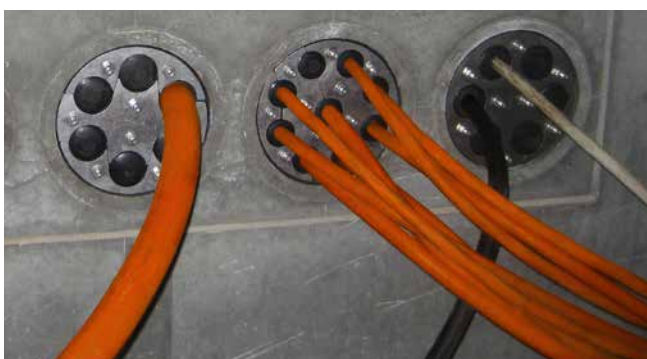
HRD150 SG eingebaut in Faserzementfutterrohre
