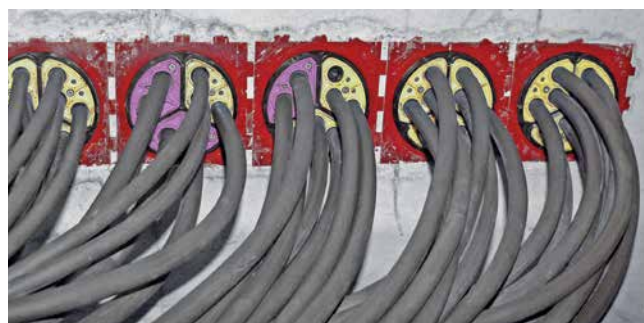
Kabelzug durch HSI-Dichtpackungen mit SEGMENTO-Systemeinsätzen
