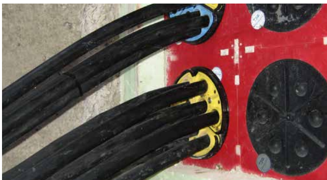
Abdichtung von Kabeln für Straßenbeleuchtung mit SEGMENTO
