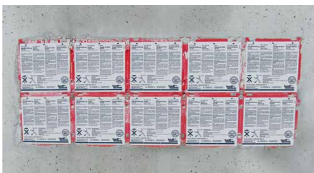
Doppeldichtpackung HSI150 als Paket
