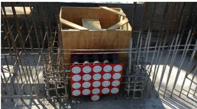
Einbau von Doppeldichtpackung HSI90 vor dem Betonieren
