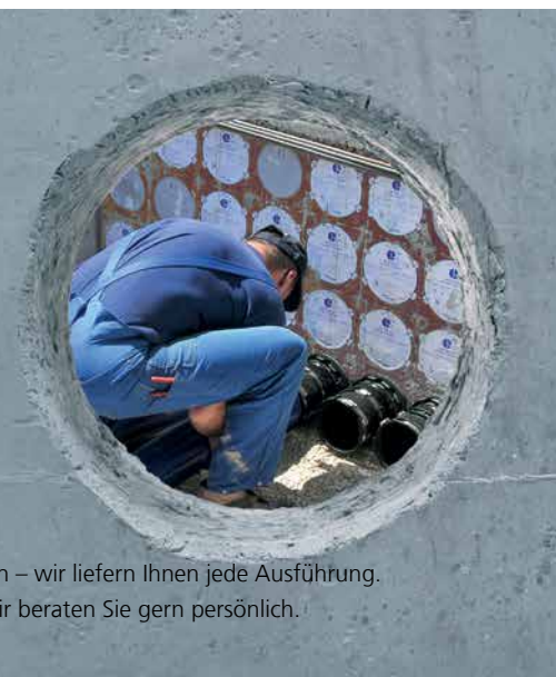
Herstellen von vertikal und horizontal verlaufenden Diamantschrägborkernbohrungen für die Aufnahme von HRD-Dichteinsätzen
