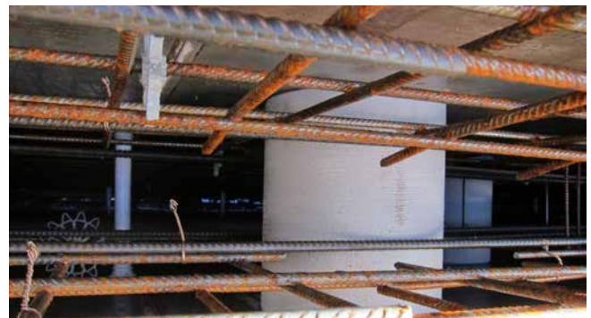
ZVR200/300 in der Schalung fixiert
