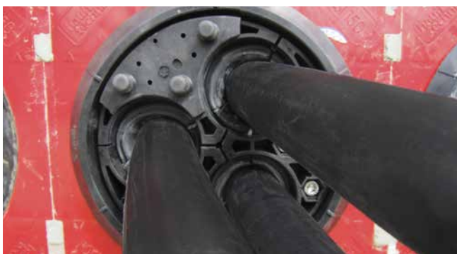
Pressplattenabdeckung HSI150 DG PA 3x24-54
