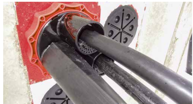
Zentrierband im Systemdeckelstutzen des HSI150 D3x58 WS
