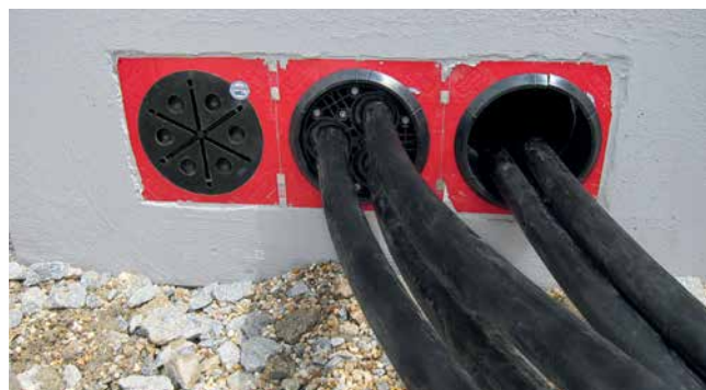
Verschiedene Montageschritte bei HSI150 DG 3x24-54
