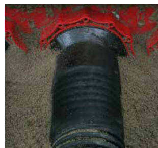
Wellrohranschluss mit Kaltschrumpftechnik HSI150 D1x110 KS WR
