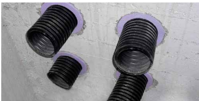
Ansicht Gebäudeinnenseite (Isoring)
