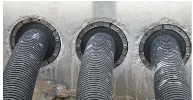
Detailansicht: Clipping/Dichtung
