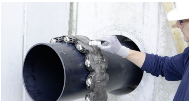
GKD400 - Montagevorbereitung mit Gleitmittel GM
