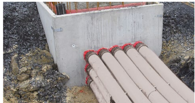
KES MA90 D - Anschluss an Dichtpackung HSI90
