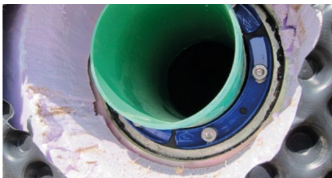
HSD150 C 1x110 b40 A2/EPDM55 in verzinktem Fest- und Losflansch
