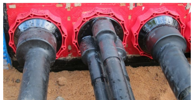
Zentrierband im Systemdeckelstutzen des HSI150 D3x58 WS
