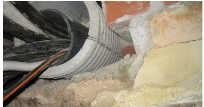
FZRG150/350 - Renovierung Mauerwerk
