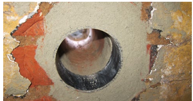
SFR nachträglich im Mauerwerk eingearbeitet
