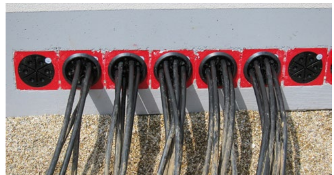
Abdichtung von Niederspannungskabeln mit HSI150 DG 6x10-36
