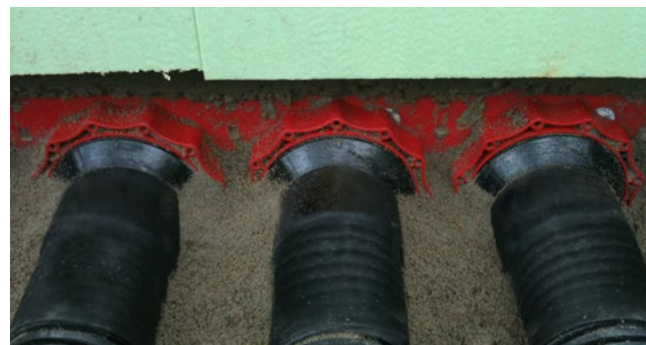
Wellrohranschluss mit Kaltschrumpftechnik HSI150 D1x110 KS WR
