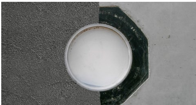
Betoniertes UFR mit PMBC
