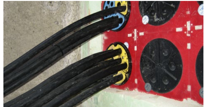
Abdichtung von Kabeln für Straßenbeleuchtung mit SEGMENTO
