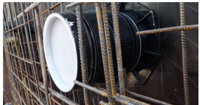
UFR in Schalung
