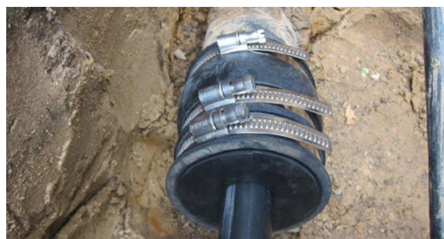
Abdichtset KES90 MA WE100 SG 1x18-65 SET zur Kabelabdichtung am Ende des Kabelschutzrohres
