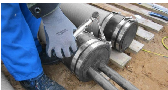
Druckdichter Anschluss des Hateflex14090 an die Dichtpackung HS190 sowie Endabschluss des Kabelschutzrohres
