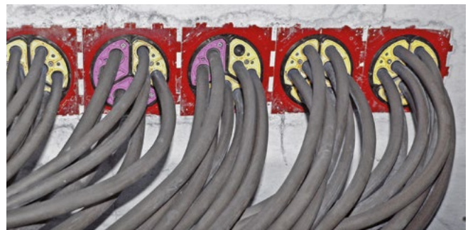
Kabelzug durch HSI-Dichtpackungen mit SEGMENTO-Systemeinsätzen
