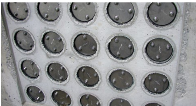
FZR100/240 Abdichtung Rohrtrasse
