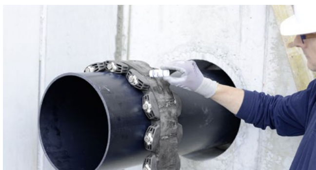
GKD400 - Montagevorbereitung mit Gleitmittel GM
