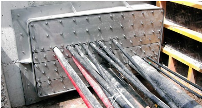
Geteilter Rechteck-Flansch mit Mehrfachbelegung
