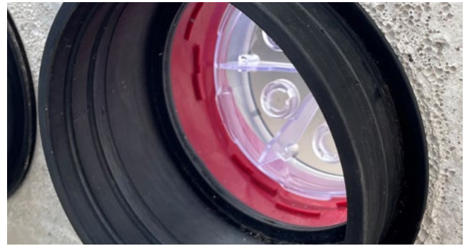
HSI150 KMA, Einfach-Dichtpackung mit klappbarer Gummimanschette
