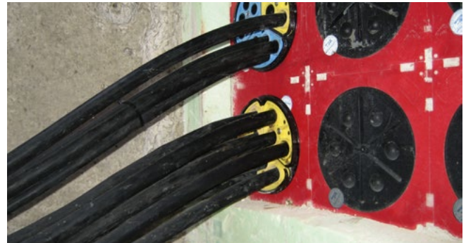
Abdichtung von Kabeln für Straßenbeleuchtung mit SEGMENTO
