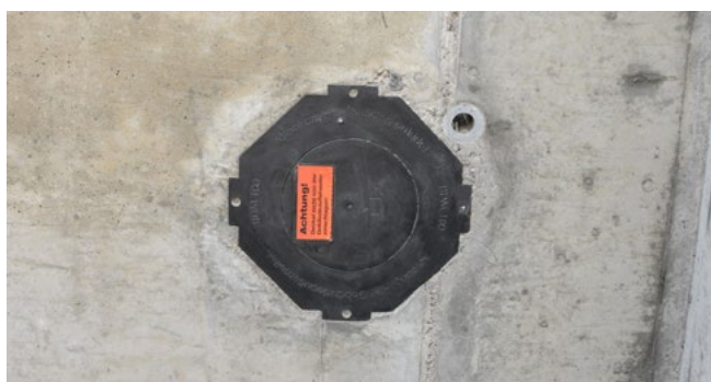
Praxisbild UDM/UDME in betonierter Wand
