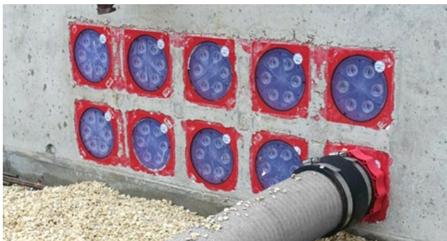
Druckdichter Anschluss an die HSI150-Dichtpackungen
