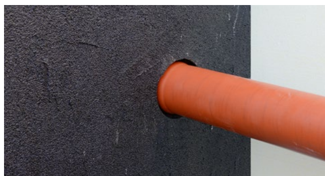
Praxisbild UDM/UDME eingebaut mit angearbeiteter PMBC-Beschichtung und angeschlossenem KG-Rohr
