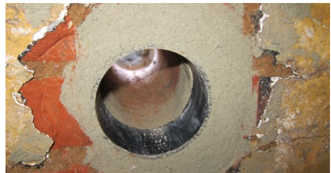
SFR nachträglich im Mauerwerk eingearbeitet
