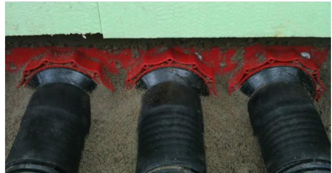
Wellrohranschluss mit Kaltschrumpftechnik HSI150 D1x110 KS WR
