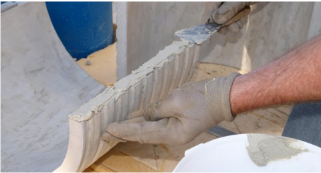
FZRG350/300 mit Spachtelmasse aus Montageset MSET FZRG
