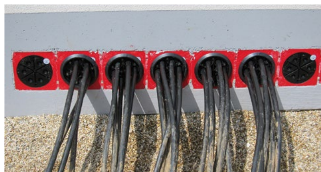
Abdichtung von Niederspannungskabeln mit HSI150 DG 6x10-36
