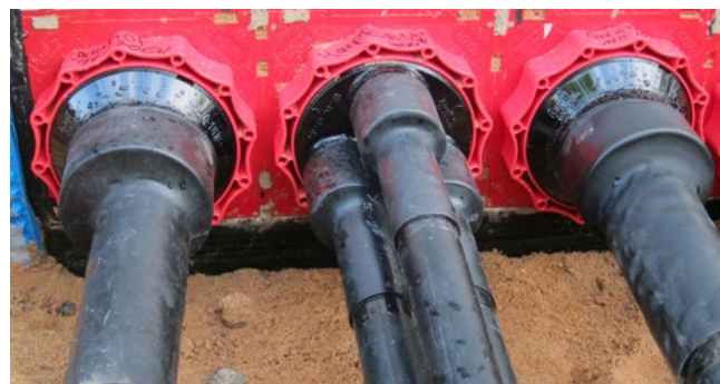
Zentrierband im Systemdeckelstutzen des HSI150 D3x58 WS
