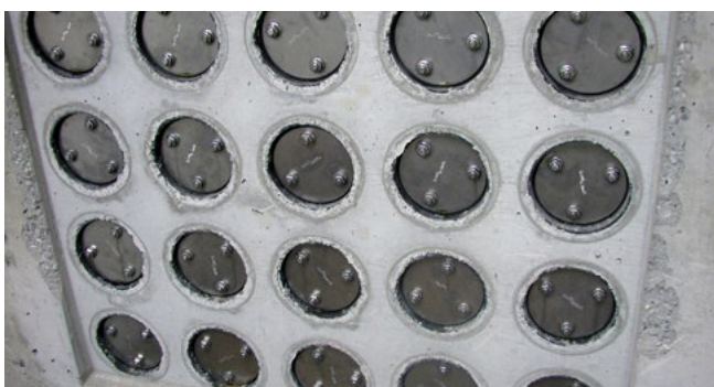
FZR100/240 Abdichtung Rohrtrasse
