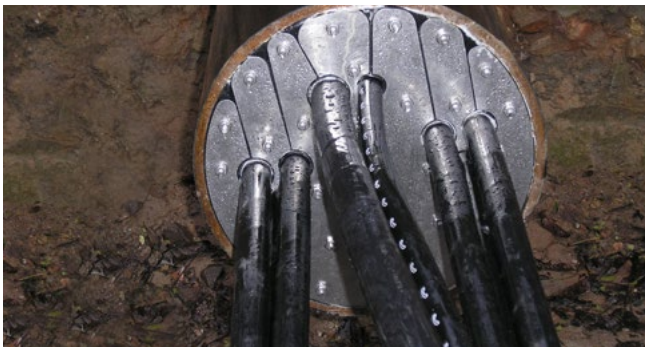
HRD200 G b30 in einem Stahlrohr
