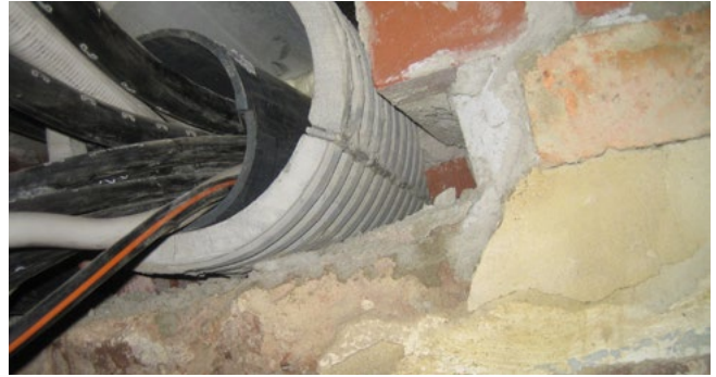
FZRG150/350 - Renovierung Mauerwerk
