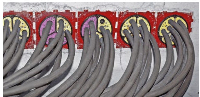
Kabelzug durch HSI-Dichtpackungen mit SEGMENTO-Systemeinsätzen
