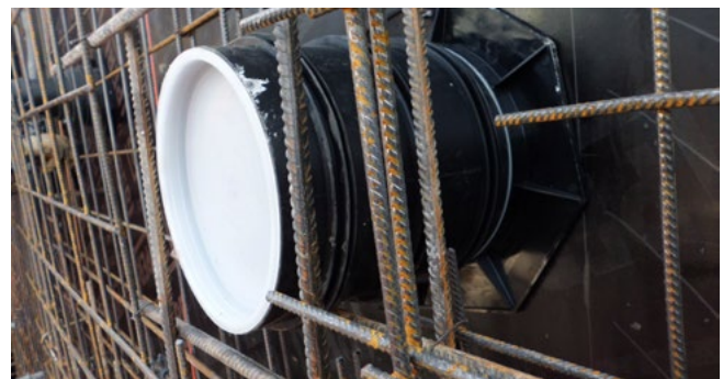
UFR in Schalung
