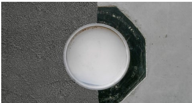
Betoniertes UFR mit PMBC
