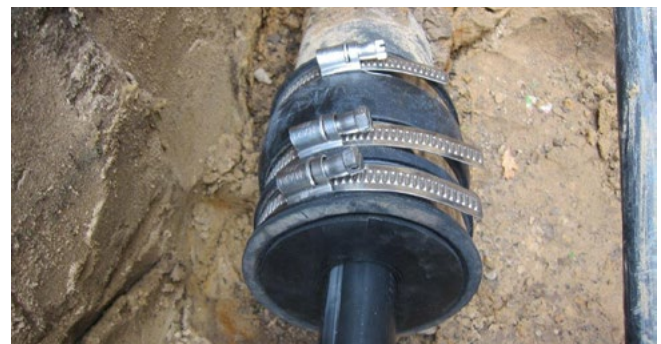
Abdichtset KES90 MA WE100 SG 1x18-65 SET zur Kabelabdichtung am Ende des Kabelschutzrohres
