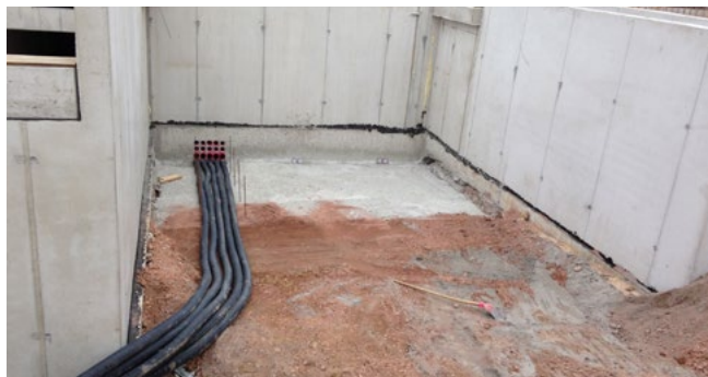
Wellrohranschluss HSI90 D1x75 KS WR
