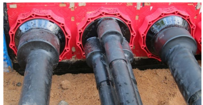
Zentrierband im Systemdeckelstutzen des HSI150 D3x58 WS
