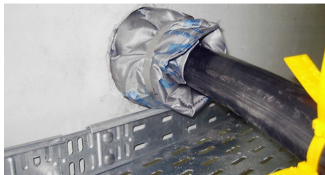
HSS - Einbau in Kernbohrung mit HRD Ringraumdichtungen
