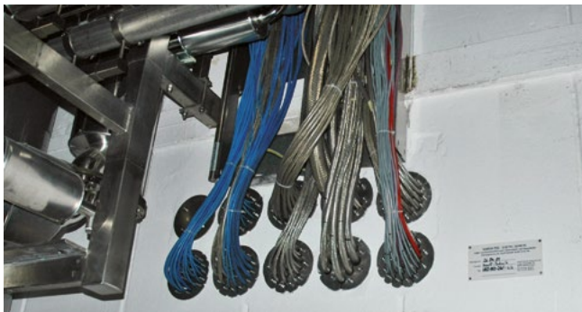
HRD150 G b30 mit Mehrfachbelegung
