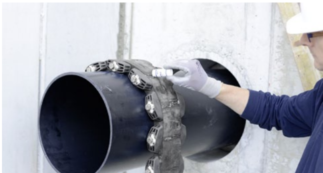
GKD400 - Montagevorbereitung mit Gleitmittel GM
