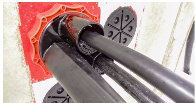
Zentrierband im Systemdeckelstutzen des HSI150 D3x58 WS
