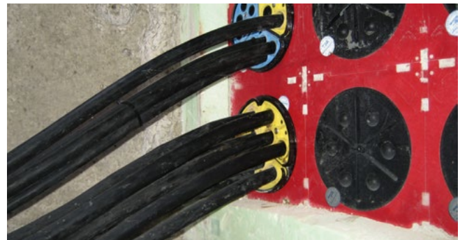
Abdichtung von Kabeln für Straßenbeleuchtung mit SEGMENTO
