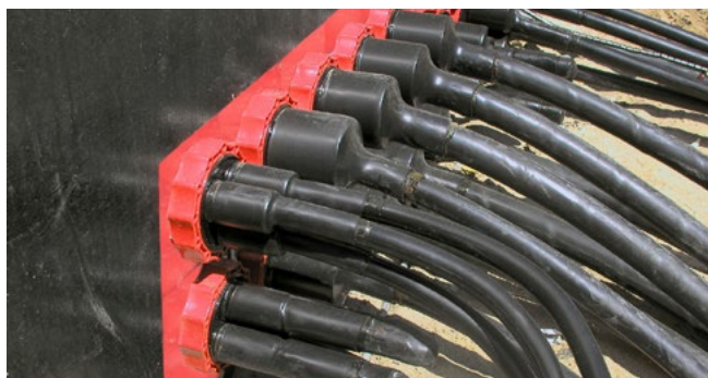
Stationseinführung: Niederspannungskabel abgedichtet mit HSI90 D1x75 WS und HSI90 D3x32 WS
