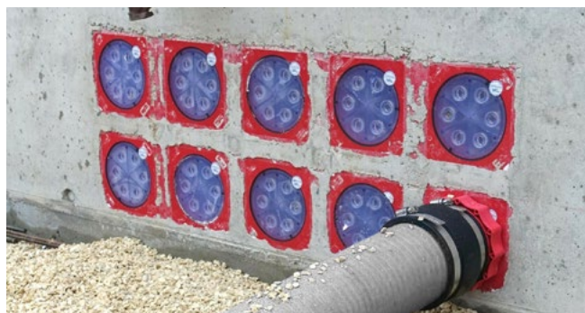
Druckdichter Anschluss an die HSI150-Dichtpackungen
