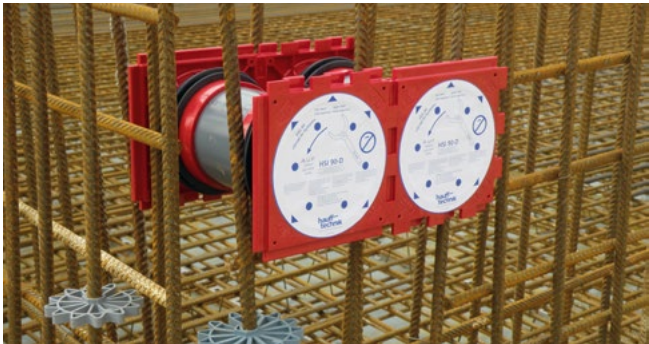
Doppeldichtpackung HSI90 als Paket in Schalung eingesetzt
