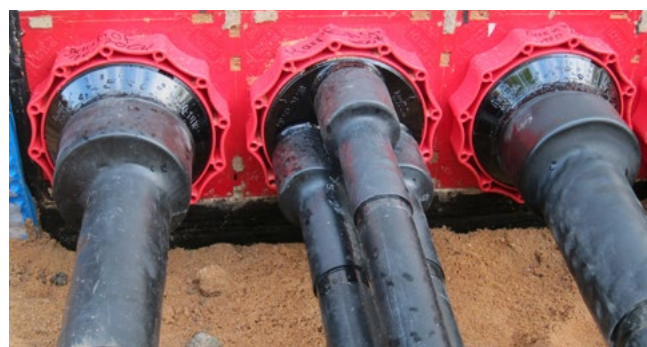
Zentrierband im Systemdeckelstutzen des HSI150 D3x58 WS
