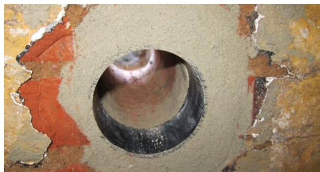
SFR nachträglich im Mauerwerk eingearbeitet
