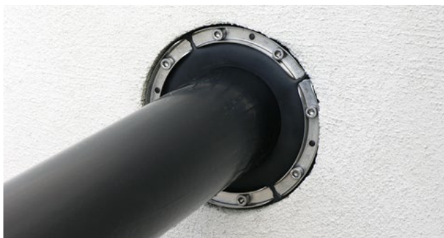
HSD200 1x159 b20 A2/EPDM55 „Schachtabdichtung“
