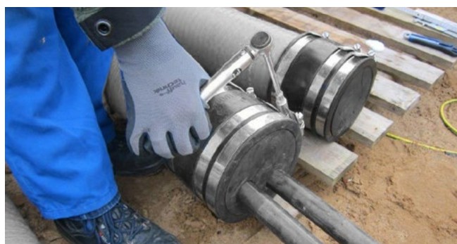
Druckdichter Anschluss des Hateflex14090 an die Dichtpackung HS190 sowie Endabschluss für das Kabelschutzrohr
