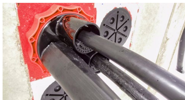
Zentrierband im Systemdeckelstutzen des HSI150 D3x58 WS
