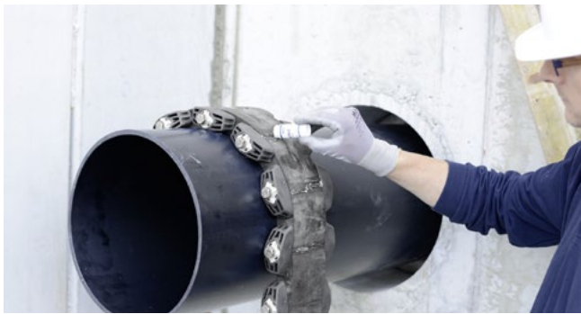
GKD400 - Montagevorbereitung mit Gleitmittel GM
