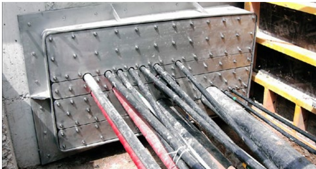
Geteilter Rechteck-Flansch mit Mehrfachbelegung
