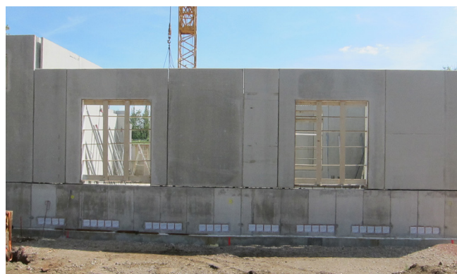
Za različne napeljave so bile uporabljeni kompleti uvodov HSI150 v različnih velikostih.
