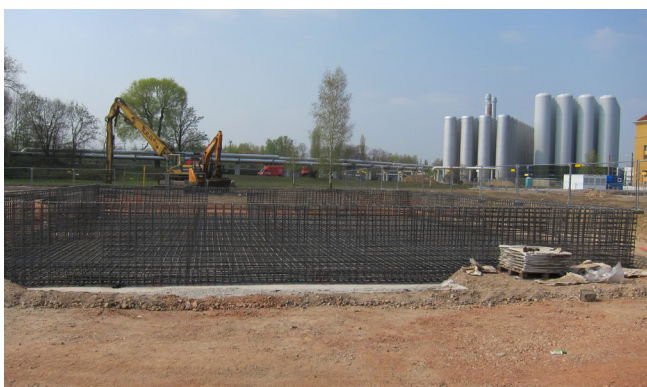
Het beton voor het stuurgebouw is in meerdere fasen gestort.
