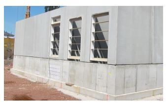
Dopo aver gettato il seminterrato in loco, l'edificio operativo è stato costruito sotto forma di pareti prefabbricate in calcestruzzo.
