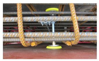
Oltre ai passacavi, sono stati usati anche ingressi di messa a terra con opzione di collegamento all'armatura, per la realizzazione.
