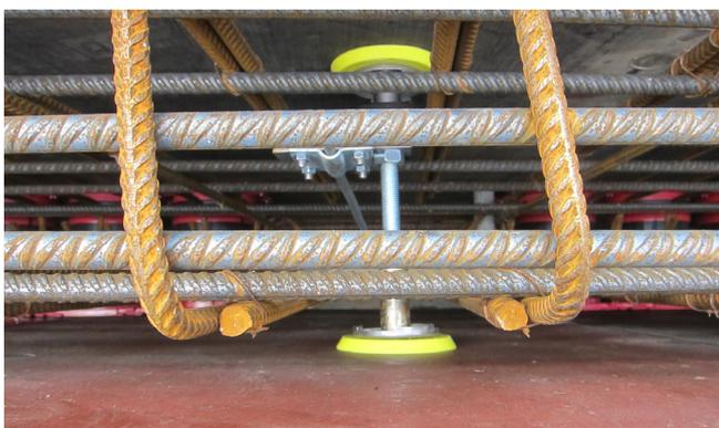
Además de entradas de cable también se implementaron entradas de derivación a tierra con posibilidad de conexión a la armadura.
