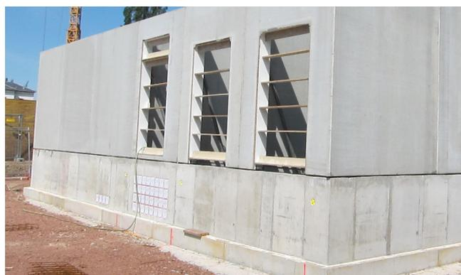
Tras hormigonar el sótano en la obra, posteriormente el edificio de servicio se construyó con paredes prefabricadas de hormigón.
