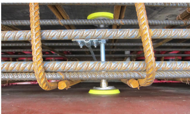
除了电缆穿入装置,可连接钢筋的接地引入装置 连同施工安装。
