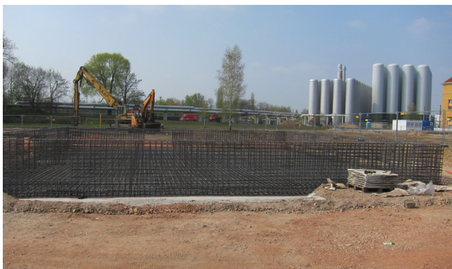
业务所大楼的混凝土浇筑分多个阶段进行施工。
