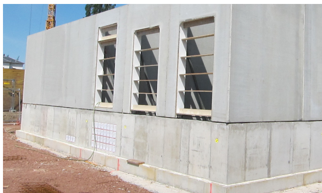
在地下室现场混凝土浇筑后,业务所大楼通过预制混凝土墙体的形式修建而成。
