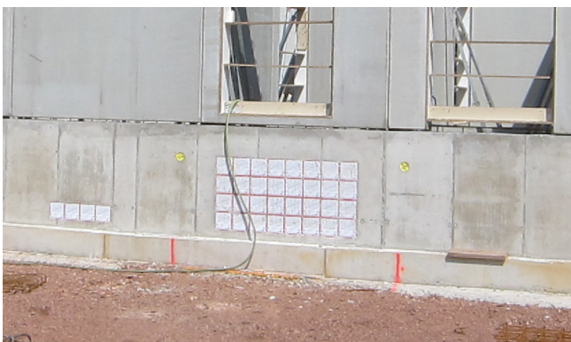
Die HSI150 in Paketanordnung ist die optimale Lösung für die Kabeleinführung. Dadurch kann eine hohe Belegungsdichte mit minimalen Platzbedarf realisiert werden.
