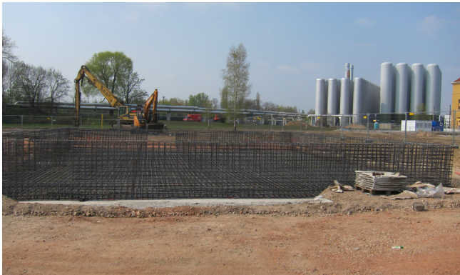
Das Betriebsgebäude wurde in mehreren Abschnitten betoniert.
