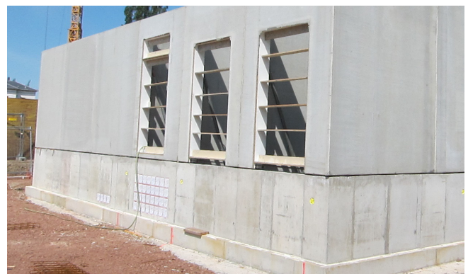
Nach Betonieren des Kellers vor Ort wurde im Anschluss das Betriebsgebäude in Form von Fertigbetonwänden aufgebaut.
