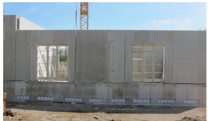
Unterschiedliche Einführungssituationen wurden mit unterschiedlich großen Paketvarianten der HSI150 realisiert.
