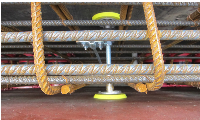
Neben Kabeldurchführungen kamen auch Erdungsdurchführungen mit Anschlussmöglichkeit an die Bewehrung, zur Ausführung.
