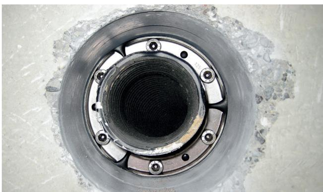
montiertes Abdichtset ADS 125/75 in einer Kernbohrung
