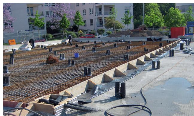
vorbereitete Bodenplatte zum Betonieren mit insgesamt 800 verlegten Wellrohren
