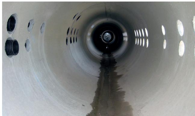
Innenansicht eines Betonrohres mit z.T. verlegten Wellrohren
