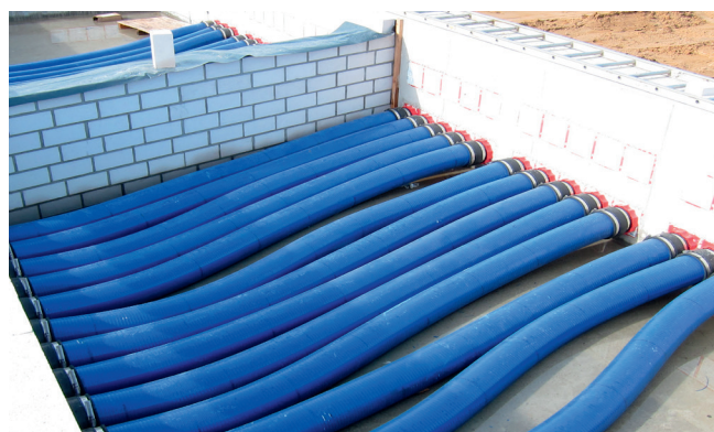
Sustavi KES 14090 priključuju se pomoću principa manžeta na ubetonirane zidne uvodnice HSI 90.
