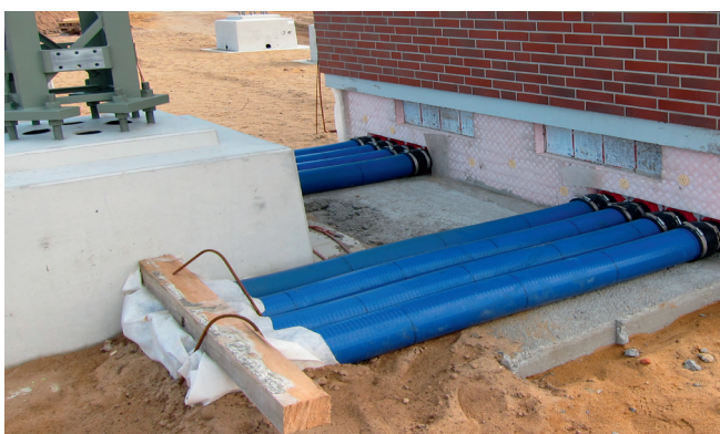
Sustavi KES 14150 priključuju se pomoću principa manžeta na ubetonirane zidne uvodnice HSI 150.
