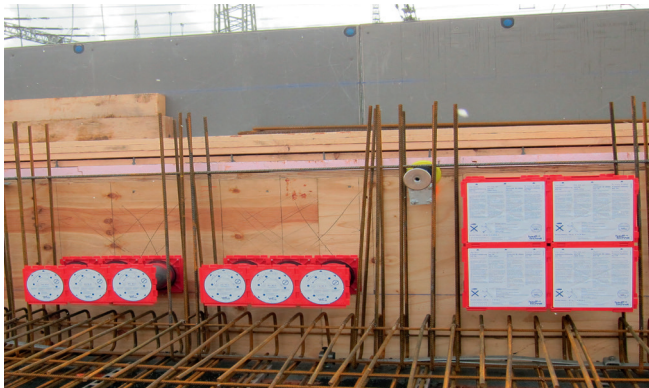
Zidne uvodnice HSI 90 i HSI 150 te uvodi uzemljenja ugrađuju se u oplatu.
