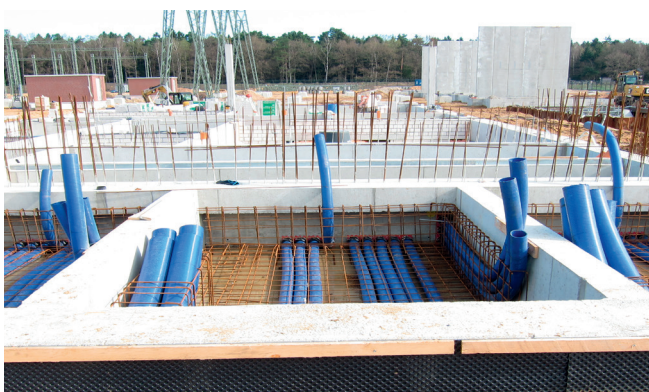
Polaganje crijeva i priključivanje zidnih uvodnica pomoću principa manžeta.
