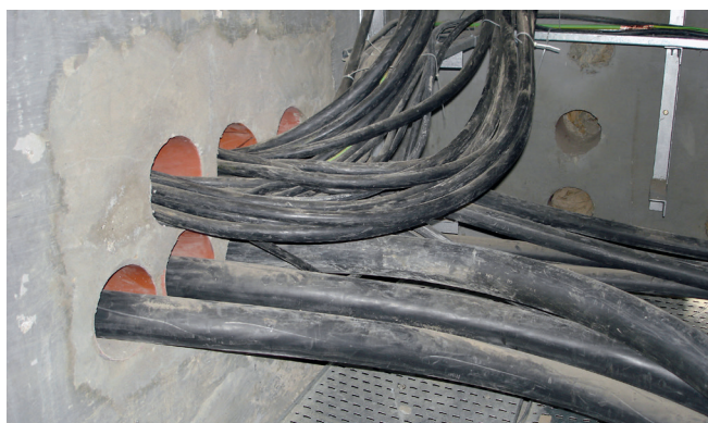
Widok z wnętrza budynku, kilkanaście kabli o różnych średnicach wprowadzone i zarobione na urządzeniach.
