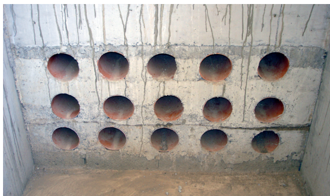
Widok z wnętrza budynku, zabetonowane rury przepustowe, niektóre zdeformowane, użyte jako otwory zapasowe.
