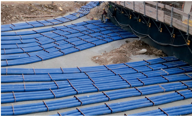
Exakte Fixierung der Hateflex-Spiralschläuche mit den Abstandhalter KES 150-2x3 KA für eine optimale Bodenverdichtung und spätere Kabelverlegung.
