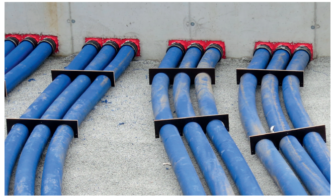
Druckdichter Anschluss der Hateflex -Spiralschläuche mittels Manschettentechnik an die einbetonierten Kabeldurchführungen HSI 150.
