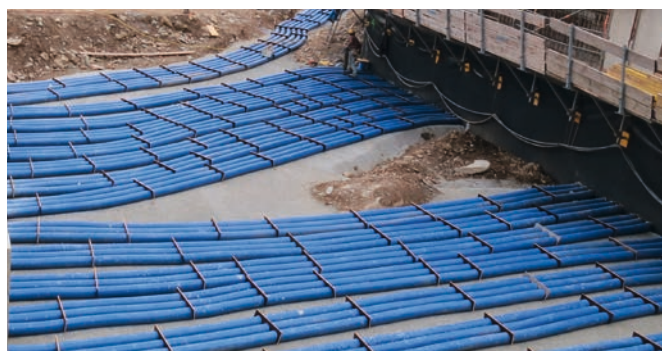
Exakte Fixierung der Hateflex-Spiralschläuche mit den Abstandhaltern KES 150-2x3 KA für eine optimale Bodenverdichtung und spätere Kabelverlegung.
