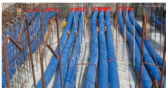
Die Kabeleinführungssysteme KES-M150 verlaufen unter der Bodenplatte und gewährleisten eine sichere Kabelverlegung im überbauten Bereich. Über das Kabelschutzrohrsystem werden die Umspanner aufgestellt.
