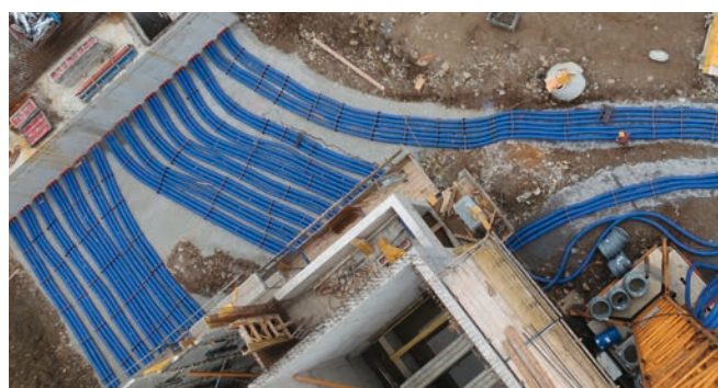
Die Kabelkeller des Umspannwerks werden mit den druckdichten, flexiblen und mechanisch stabilen Kabeleinführungssystemen KES-M150 verbunden.
