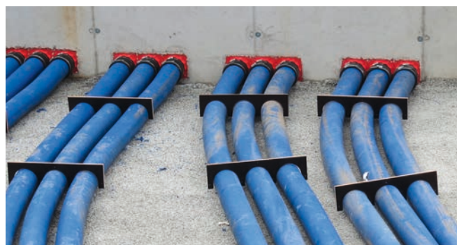
Druckdichter Anschluss der Hateflex -Spiralschläuche mittels Manschet-ententechnik an die einbetonierten Kabeldurchführungen HSI 150.
