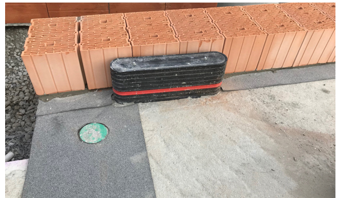
Rohbauteil der MSH Basic - FUBO - R5 in der Bodenplatte
