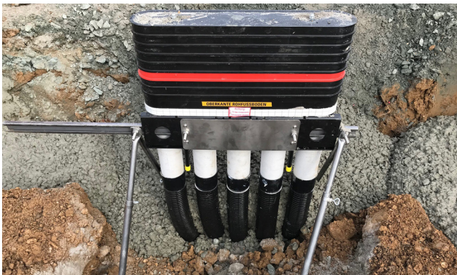
Rohbauteil der MSH Basic - FUBO - R5 mit Aufstellvorrichtung MSH Basic - FUBO - FIX im Versorgungsgraben positioniert und versandet. Leerrohre im Streifenfundament einbetoniert.
