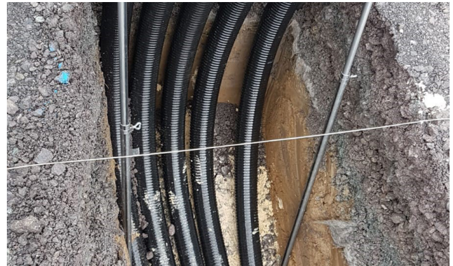
Biegeradius 1m zur problemlosen, späteren Einführung der Versorgungsleitungen. Rohbauteil am Schnurgerüst eingemessen.
