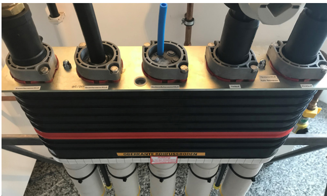
Spätere Belegung der Mehrspartenhauseinführung durch den Versorger mit Trinkwasser, Strom, Telekommunikation, Nahwärme Vor- und Rücklaufleitung.
