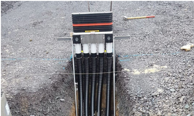
Rohbauteil der MSH Basic - FUBO - R5 mit Aufstellvorrichtung MSH Basic - FUBO - FIX im Rohrgraben positioniert. Saubere Verlegung der Leerrohre im Kabelgraben.
