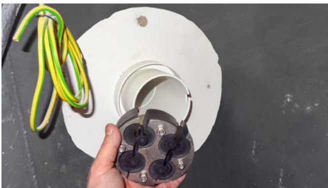
Montage einer Abschottung HSS mit druckdichter Kabelabdichtung HRD100-SG kombinierbar mit HVS Kissen von einer Seite
