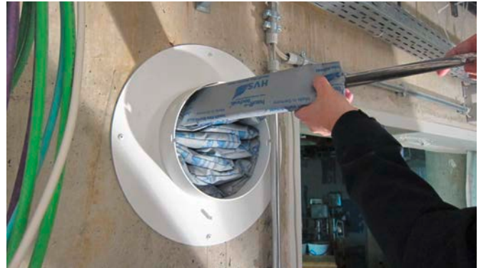
HVS Kisseneinbau mit Montagesteckblech
