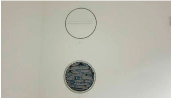
HVS Kabelschottung (Szenographie); oben: mit Verschlussdeckel unten: gefüllt mit Brandschutzkissen, ohne Kabelbelegung
