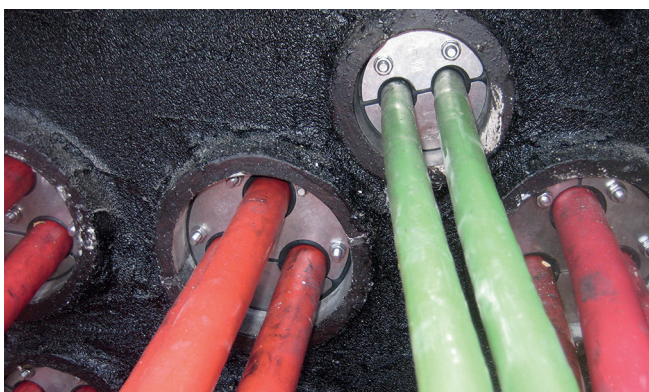
Alla kablar tätades i efterhand med delade, måttillverkade HRD-presstättningar i foderrören.
