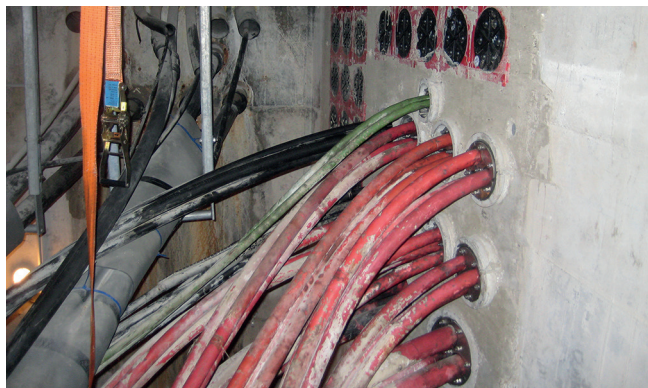
Az átvezetőcsatorna állapota a felújítás után: tartalékátvezetések alakítottak ki. A telepített kábelek köré osztott védőcsöveket szereltek, így biztosították a fal, a védőcső és a kábel tömítettségét.
