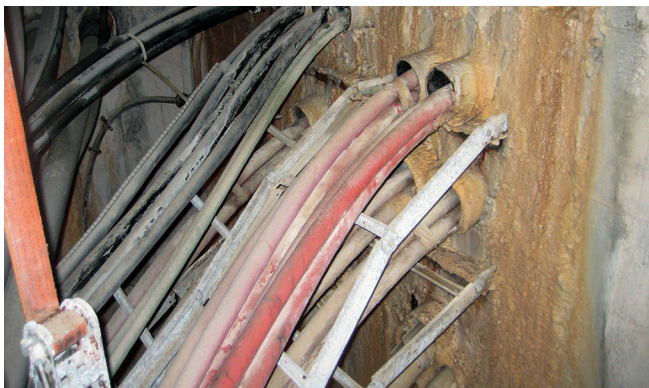
Az átvezetőcsatorna állapota a felújítás előtt: víz szivárgott be a védőcsövek és kábelek, valamint a védőcsövek és a fal között.
