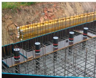
Bodenplattendurchführung WEH 100-/ GEH 100-/ EEH 100-FUBO für Wasser-, Gas-, Strom- und Telekommunikationsanschluss.
