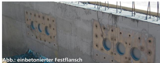
Abb.: einbetonierter Festflansch
