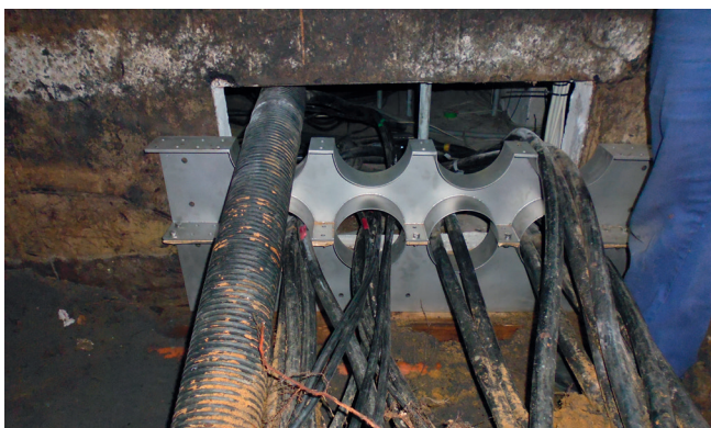
Placering av de förmonterade flänsplattorna och identifiering av monteringsläget före vägggenomföringen.
