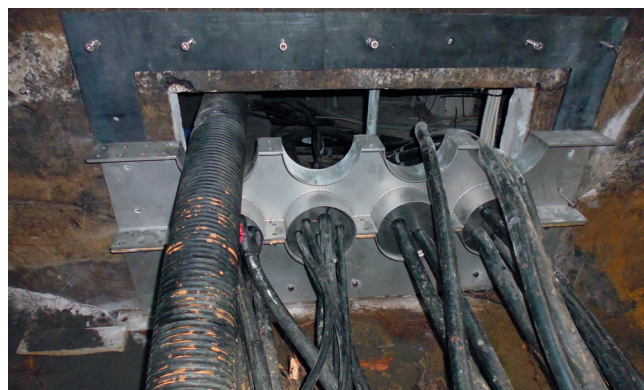
En flat tätning limmades på väggen med Sikaflex-tätningssmassa.
