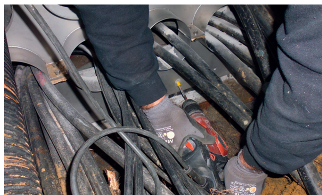
En flat tätning limmades på väggen med Sikaflex-tätningssmassa.
