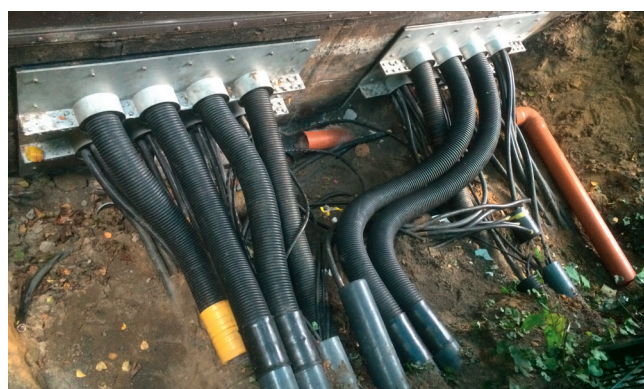
Ny vägggenomföring med kabel- och skyddsörnsdiken före igenfyllning.
