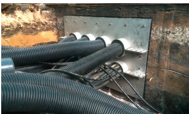
Färdigmonterad flänsplatta med kabel- och rörgenomföringar.
