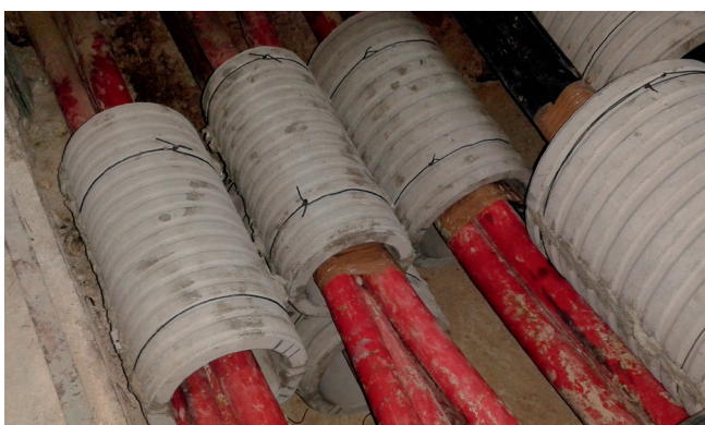
Detajlna slika iz katere se vidi, da sta polovici zlepljeni skupaj
