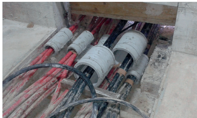
Izrez okna v steni in montaža deljivih cementnih uvodnic FZR-G, ki omogočajo sanacijo obstoječega stanja kablov.
