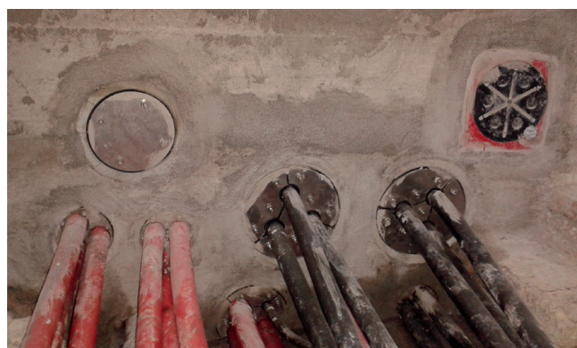
Končna situacija izdelana s Hauff Technik elementi
