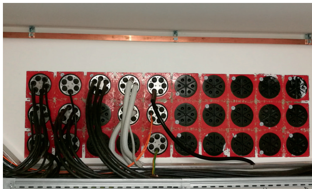
Vgrajena standardna tesnilo HRD 150-SG z adapterjem HSI 150-ARG-150 SG v uvodnicah HSI 150-K...
