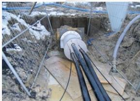
4 150 KV Seekabel Druckdichte Einführung der einzelnen Hochspannungskabel und LWL-Datenkabel am Umspannwerk für die Einspeisung in das 380KV/50Hz Versorgungsnetz.
