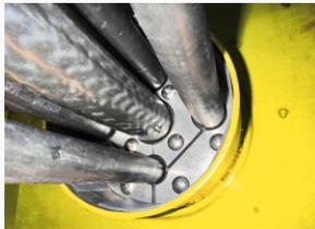
3 150 KV Seekabel Landanbindung HS-Kabeltrasse 150 KV in Kombination mit LWL-Datenkabel in einer Spundwand.
