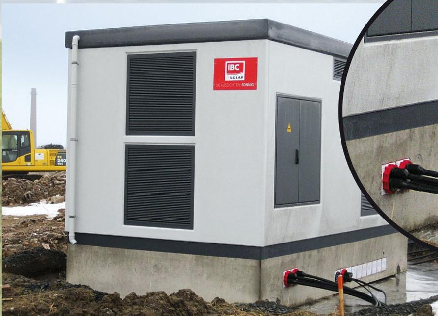
**Trafostation einer Onshore-Windkraftanlage: Die Kabelabdichtung erfolgt über die Dichtpackungen HSI 150 mit verschiedenen Systemdeckeln.**
