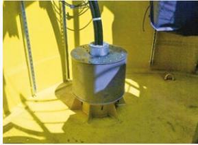
2 400 Volt Niederspannungskabel Kabeldurchführung in geteilter Ausführung auf einer Offshore-Umspannplattform. Druckdichte und dauerelastische Abschottung von Niederspannungskabeln zwischen dem Generatorraum und Kabeldeck mit geteilter Ringraumdichtung HRD 200.
