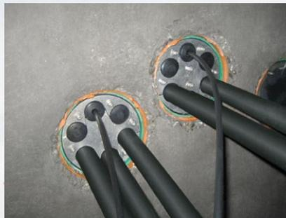
**Segmentringtechnik im Einsatz: HRD 150-SG im Fundament einer Windenergieanlage.**
