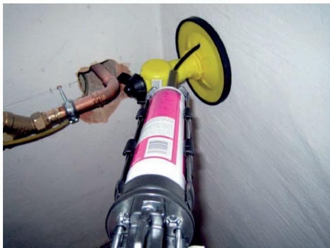
Bild 6: Expansionsmaterial wird gezielt in die Gummimembrane in der Wand eingeleitet
