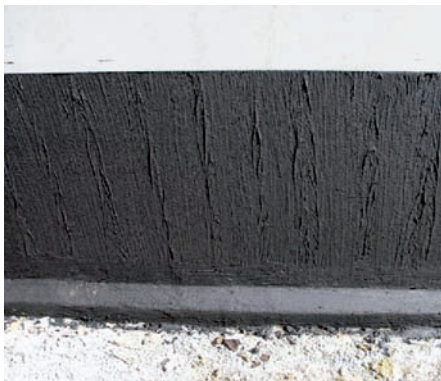
Bild 1: Kellerwand mit Außenabdichtung aus KMB
