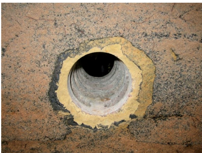
Bild 4: Kernbohrung (90 mm) für Gashausanschluss
