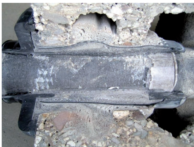
Bild 8: Positiver Einbauversuch im Mauerstein (Hauseinführung Fa. RMA)
