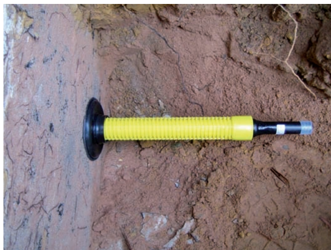
Bild 7: Fertiger Hausanschluss (Außen)
