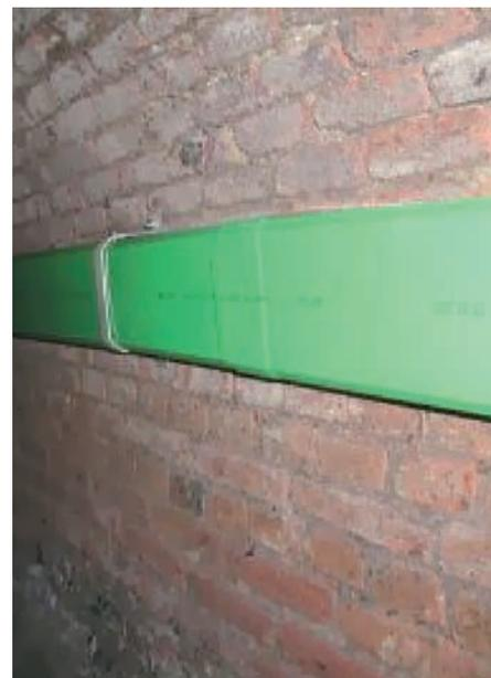
**Bild 18:** MKS-System für Glasfaserverlegung in begehbaren Kanälen [5]
