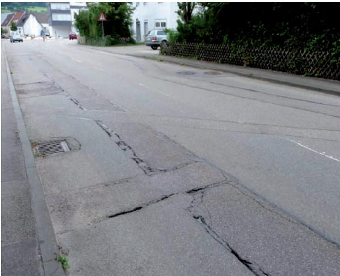
**Bild 4:** Oberflächenfolgeschäden der offenen Bauweise
