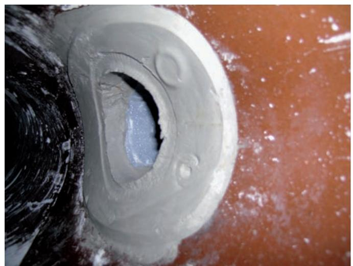
**Bild 15:** Fertig gestellter Anschluss eines flexiblen Liners
