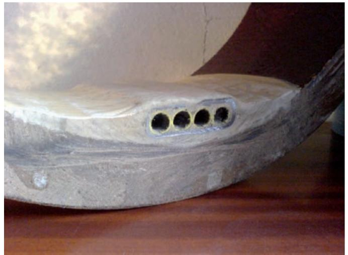
**Bild 20:** Liner mit Microduct für den Glasfasereinzug [5]
