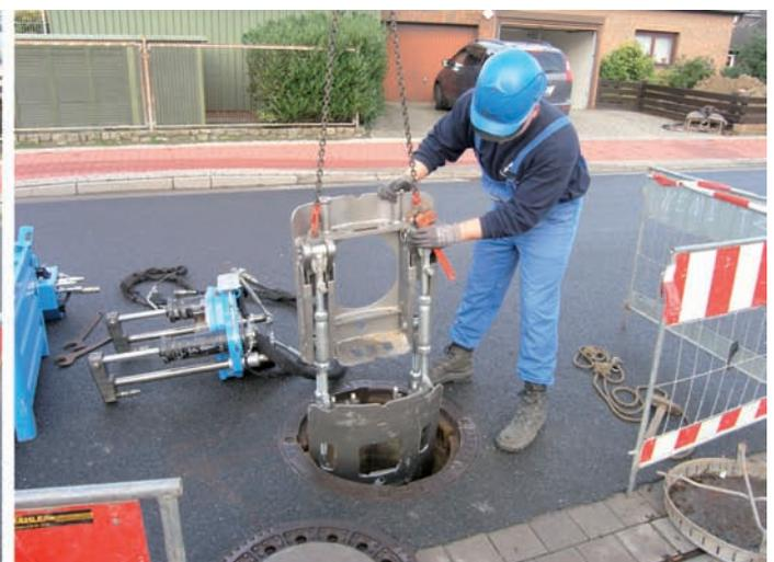
**Bild 7:** Einbau einer Grundobore-Anlage: Antransport zum Schacht (links) und Absenken des Pressrahmens in den Schacht (rechts)
