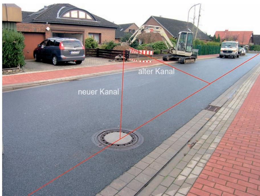
**Bild 8:** Beispiel einer Neuerlegung eines Abwasser-Hausanschlusskanals vom Schacht zum Haus
