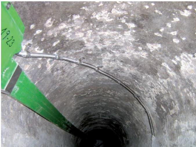
**Bild 19:** Abzweigmuffe mit Metallringschlauch zum Hausanschlusskanal führend [5]
