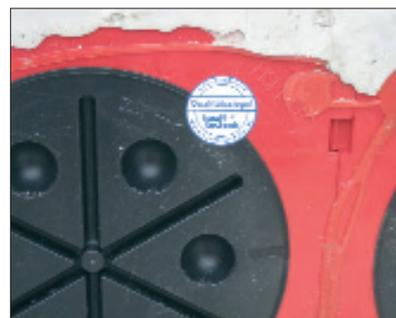
Dieses System ist ebenfalls auf den Einsatz in die einbetonierten Dichtpackungen HSI 150 abgestimmt. Es besteht aus einem Segmento-Systemdeckel mit Bajonettverschluss, der in die Dichtpackung einmontiert wird und den lichte Kreisfläche in drei Segmente/Zonen von je 120 Grad unterteilt.
