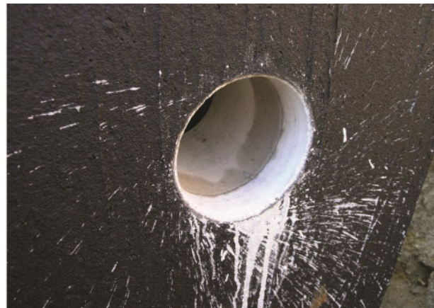
Kernbohrung in Doppel/Elementwand-Konstruktion mit Außenabdichtung
