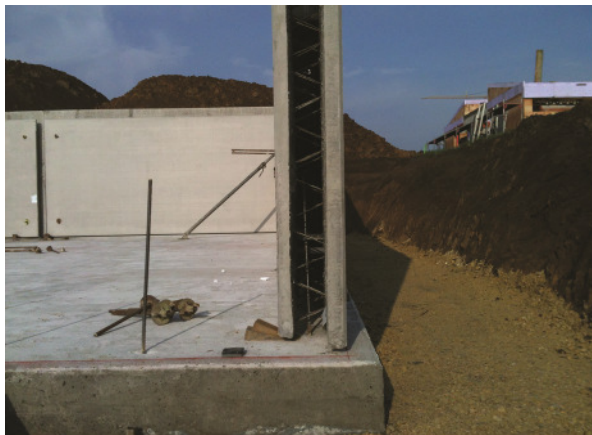
Fertiggeller als Doppel/Elementwand-Konstruktion
