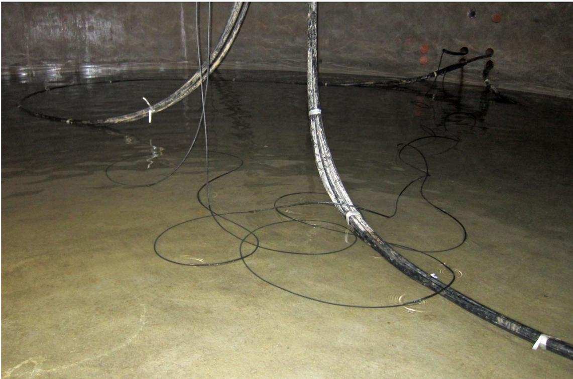
Wassereintritt im Fundament einer Windkraftanlage
