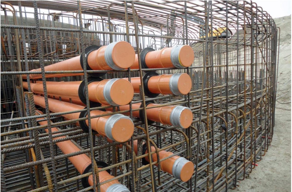
Kanalgrundrohre mit Wassersperre eingebracht in Fundamentarmierung
