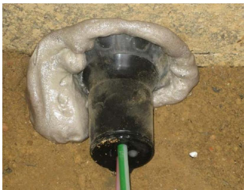
**Bild 5 und Bild 6:** No-Dig-Hauseinführung im Keller und nach einer Kontrollaufgrabung an der Außenwand
