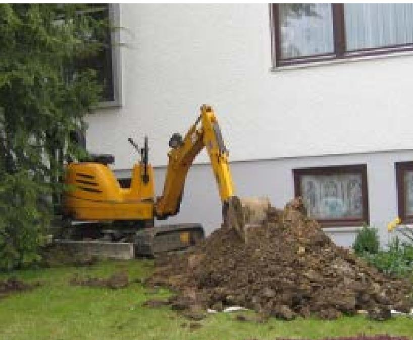
**Bild 1:** Hausanschlusserstellung mit Tiefbauarbeiten auf dem Kundengrundstück
