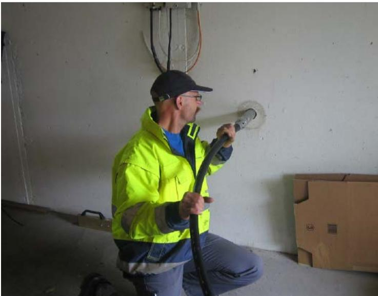
**Bild 4:** Start der „Erdverdrängsrakete“ aus dem Keller
