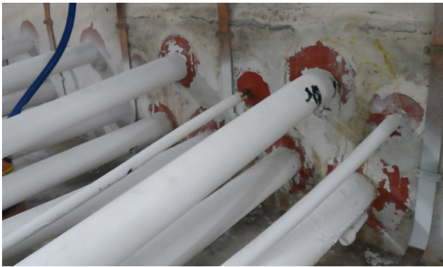
Lekkende mastiekafdichting
