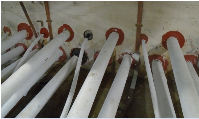
Doorgang met twee als test geïnstalleerde afdichtingen
