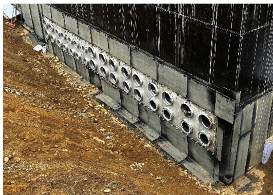
Flansch nach der Montage
