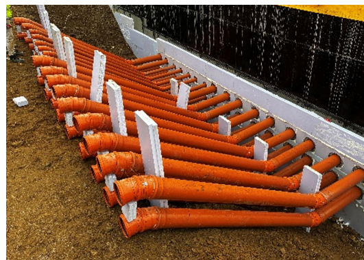
Flansch nach Einführung der Rohre
