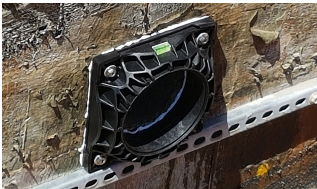
HSI 150-DFK väggfläns och tätning placerades över kärnhålet och fixerades med vattentäta skruvar och dyvlar.
