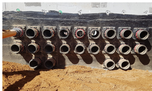
KME testade tre till att börja med, byggaren godkände sedan systemet och slutförde ytterligare ett membranskikt. Nya kärnhål borrades och därefter installerades ytterligare 22 HSI 150-DFK och tätningssatser efter goda resultat och enkel installation.
