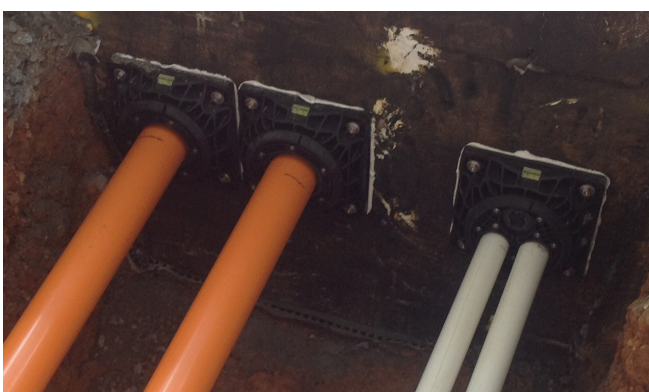
Fler tjänster lades till i projektet via mindre rör. Vårt DG-system valdes eftersom de gjorde det möjligt för KME att ansluta flera ingångar via en tätning.
