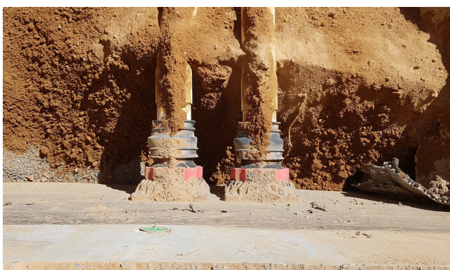
Röret ansluts sedan med gummianslutningshylsan som medföljer tätningssatsen.
