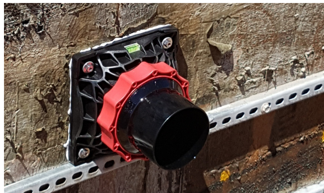
HSI-tätningssatsen monteras sedan enkelt via bajonettssystemet på DFK och dras åt med den röda fästmuttern.
