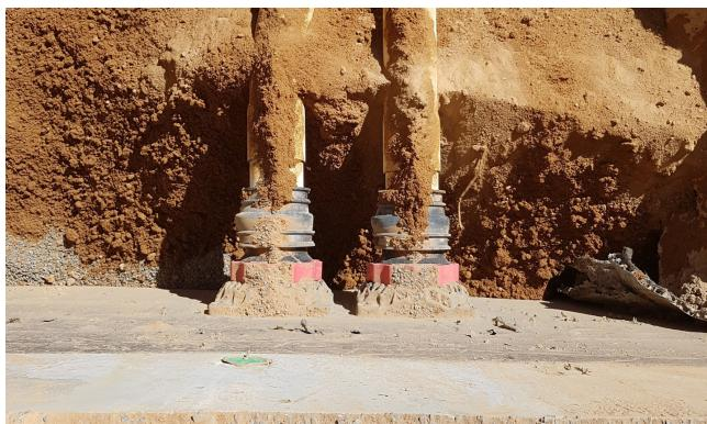
Potom je s poklopcom sustava spojena cijev s pomoću gumenog priključnog rukavca.
