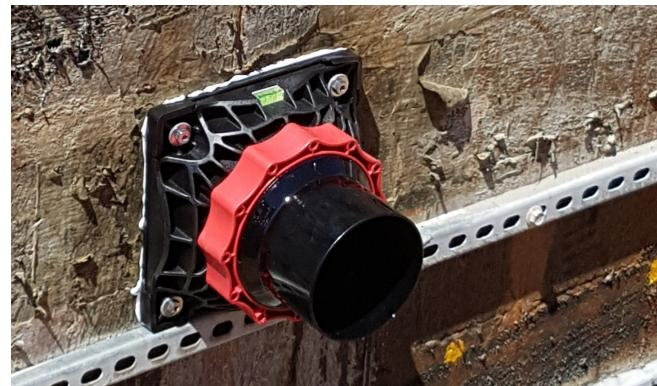
Brtveni element HSI sustava jednostavno je pričvršćen bajunetnim sustavom na DFK i zategnut crvenom steznom maticom.
