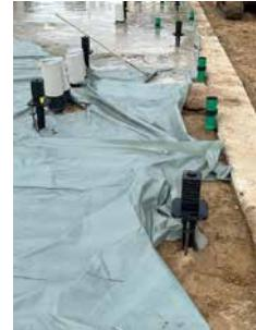
Platzieren der Bodeneinführungen und einbringen der Folie unterhalb der Sauberkeitsschicht.
