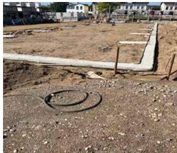
Vorbereitetes Streifenfundament für die Bodenplatte eines der neuen Gebäude.
