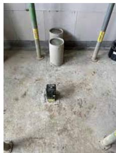
Eingebaute Hauseinführungen in der Bodenplatte des Rohbaus.
