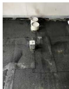
Aufgebrachte Dampfsperre mit Anbindung an die Hauseinführungen.
