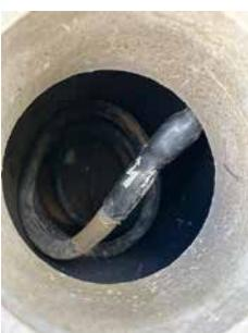
Die aufgeschlossene Stromzufuhr findet im Fundamentsystem ausreichend Platz, um dort für einen späteren Einsatz „geparkt“ zu werden.
