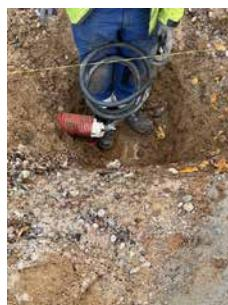
Am zukünftigen Standort wird aufgegraben und die Stromzuleitung für den späteren Anschluss der Ladesäule wird vorab spiralförmig aufgeschlossen.
