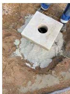
Durch eine Betonfertigmischung am Fundamentfuß erhält unsere Lösung eine zusätzliche Festigkeit.
