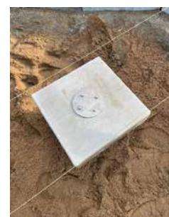
Sauberer Abschluss: ULF wird mit dem Prototyp des späteren ULF Verschlussdeckels versiegelt. Die Stromzufuhr ist sicher vor dem Zugriff Dritter geschützt.
