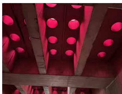
Einzelnes Feld eines Waffeltisches mit integrierten Zement-Verbund-Rohren im Rohbau auf der Reinraumbene.
