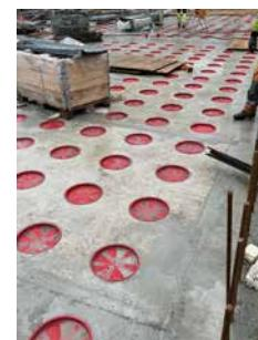
Reihe von Fertigbetonfeldern eines Waffeltisches auf der Lüftungsebene im Rohbau mit integrierten und verschlossenen Zement-Verbund-Rohren.
