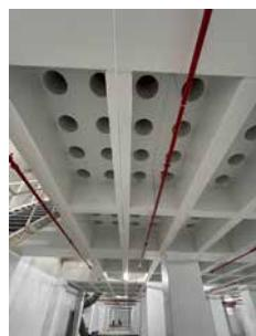
Einzelnes Feld eines fertig vorbereiteten Waffeltisches auf der Reinraumbene.
