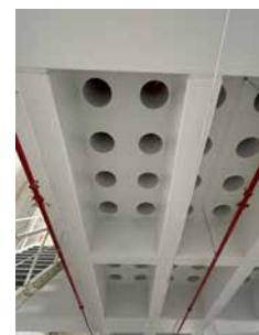
Reihe von Feldern eines fertig vorbereiteten Waffeltisches auf der Reinraumbene.
