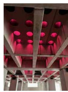
Reihe von Feldern eines Waffeltisches mit integrierten Zement-Verbund-Rohren im Rohbau auf der Reinraumbene.
