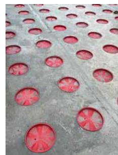
Einzelnes Fertigbetonfeld eines Waffeltisches auf der Lüftungsebene im Rohbau mit integrierten und verschlossenen Zement-Verbund-Rohren.
