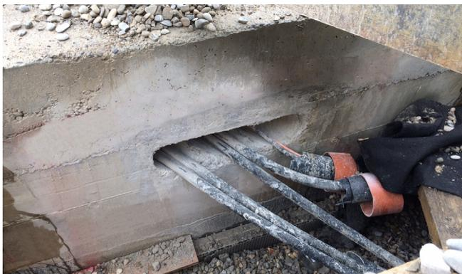
Postojeći glavni opskrbni vodovi nisu mogli biti premješteni u sklopu izvedbe prohodnog kanala za medije. Tijekom izrade građevinskog projekta ostavljen je slobodan zasjek oko kabela.
