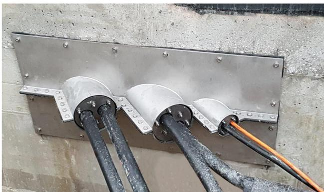
Rješenje: Izmjera dodatne prirubnice u odvojenoj izvedbi s različitim ograncima cijevnih nastavaka sukladno kutu izlaza kabela.
